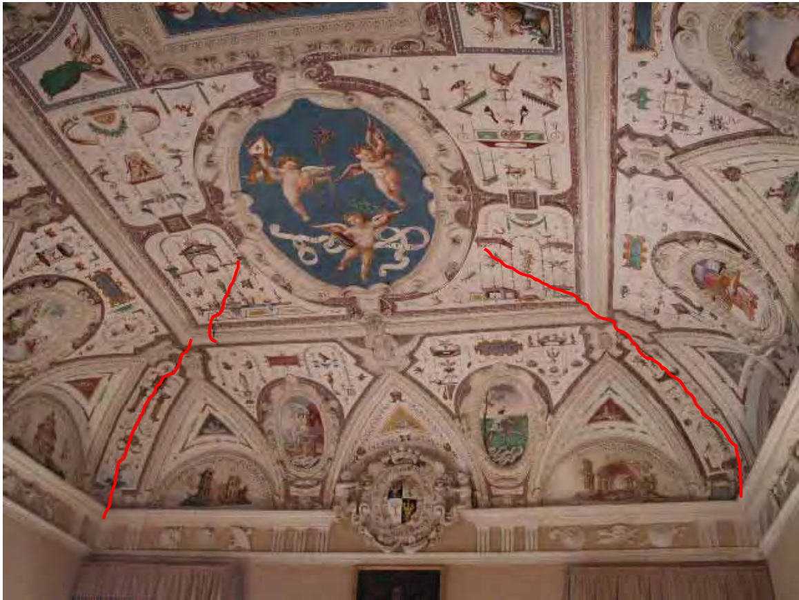
Castello della Manta Volta a padiglione lesionata del Corridoio delle Grottesche
