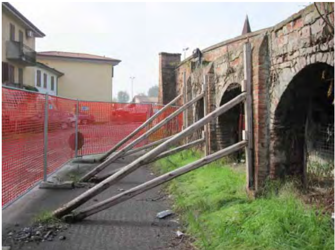
Opere provvisorie di sostegno del portico della Torre della Norma di Casalbuttano (CR)
