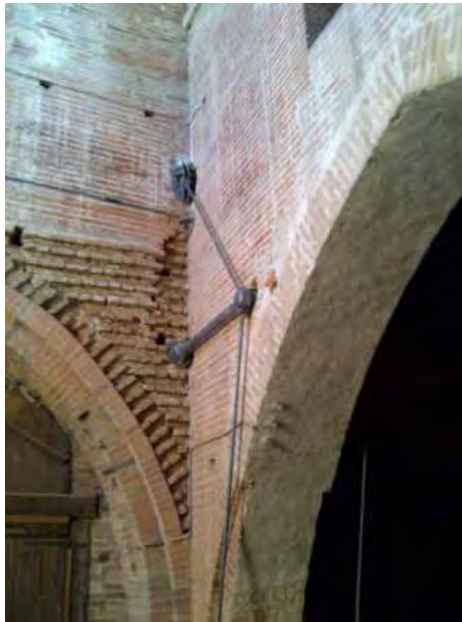
Vista dai matronei dei puntelli che tendono il cavo e trasferiscono una spinta alle imposte della navate del Duomo di Cremona
