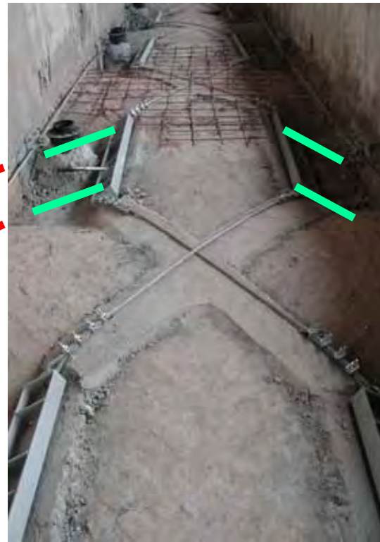
Controventi metallici della volta, collegati a profili inghisati alle reni della volta e annegati in una cappa estradossale Comune Lonate Pozzolo (Va) Ex Monastero Di S. Michele
