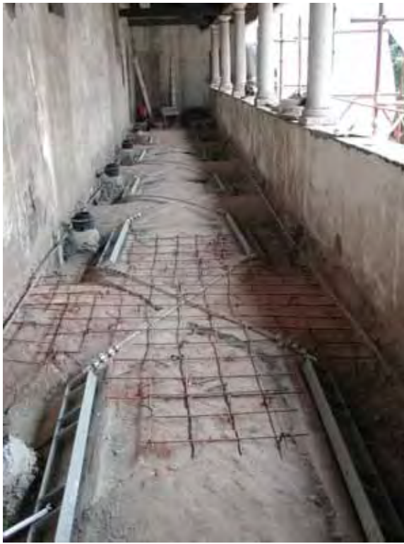
Controventi metallici della volta, collegati a profili inghisati alle reni della volta e annegati in una cappa estradossale Comune Lonate Pozzolo (Va) Ex Monastero Di S. Michele
