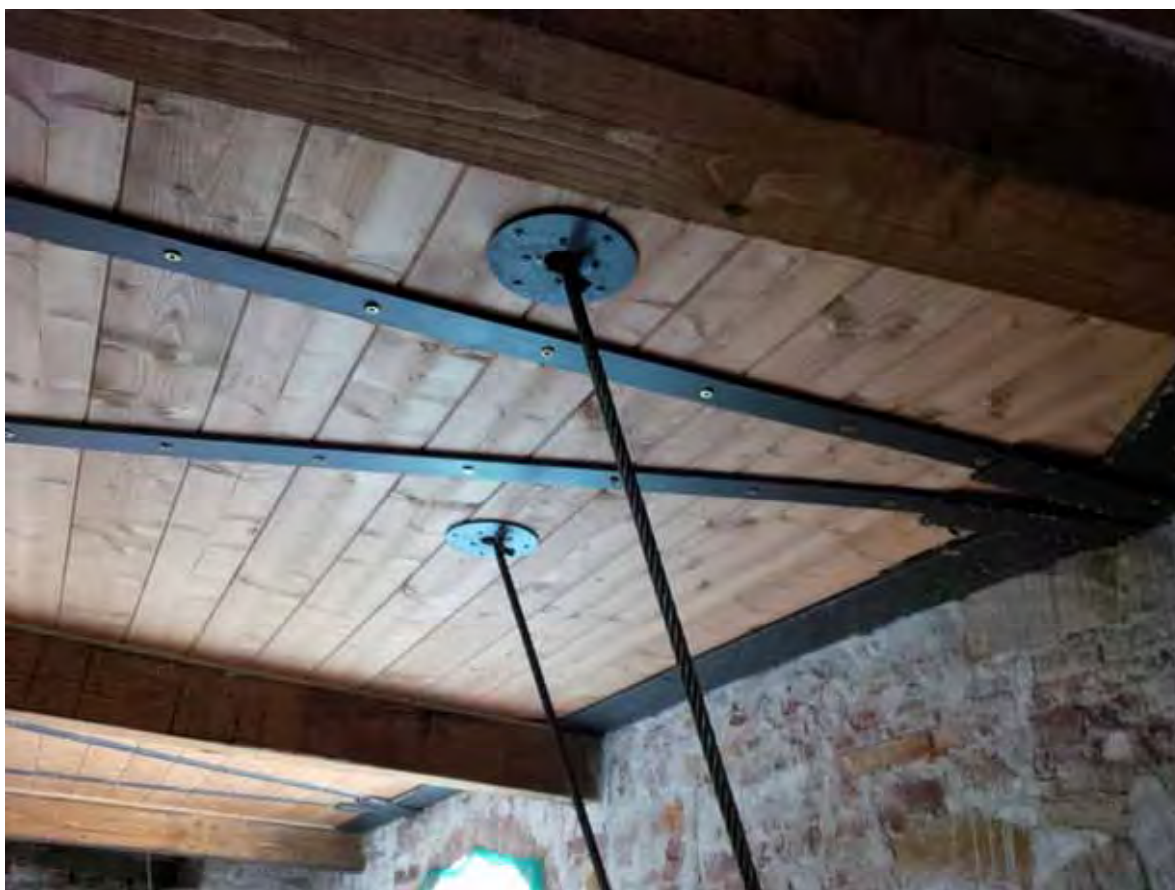
Profili in acciaio per la cerchiatura del vano, per il consolidamento dell'orditura lignea e nuovo assito ligneo
