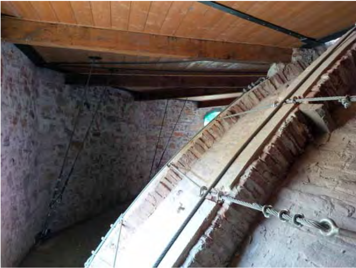
Realizzazione della cerchiatura della cupola di Santa Caterina in Lucca
