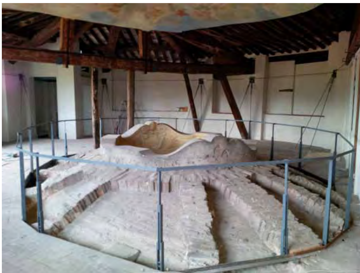
Il sottotetto della Chiesa di Santa Caterina a Lucca dopo l'intervento
