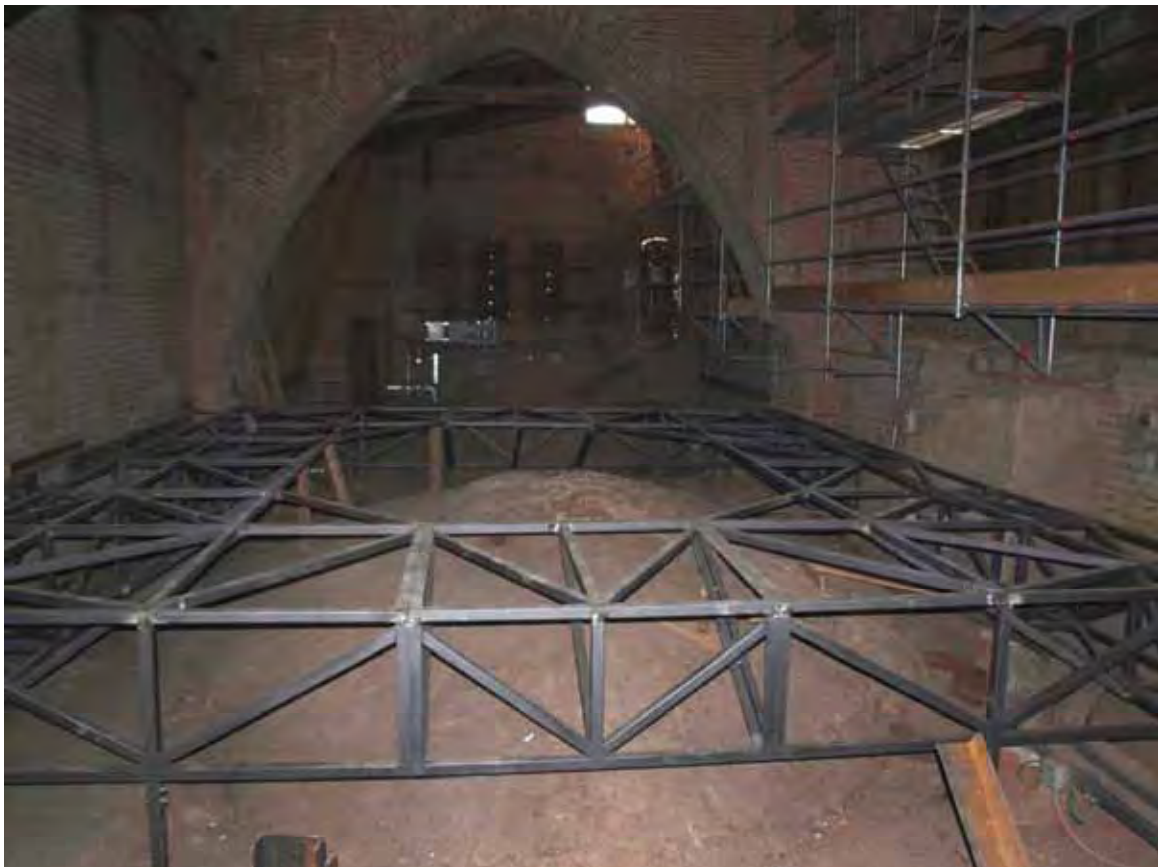
Fase di realizzazione delle reticolari metalliche dei matronei
