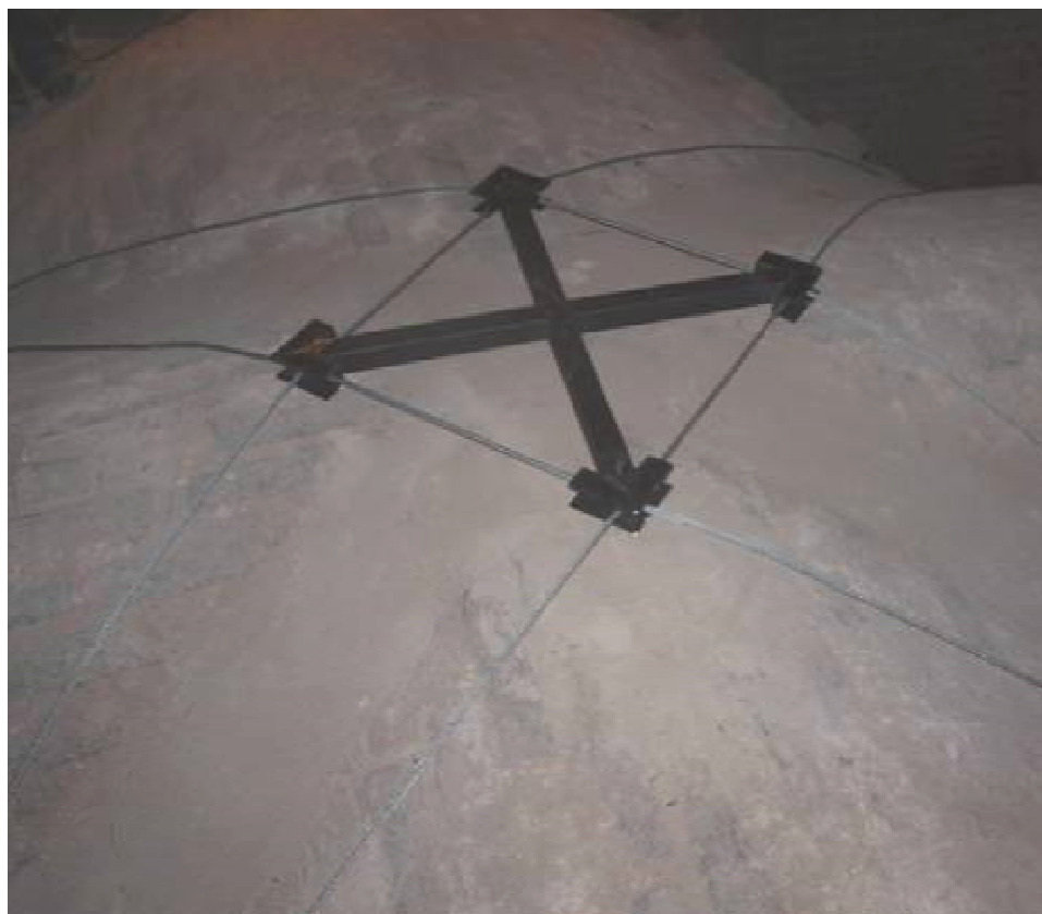
Navate centrali, interventi a livello dei matronei: realizzazione dell’arco armato “a croce” sulle volte dei transetti
