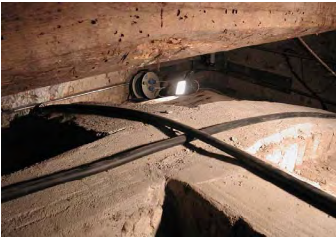
Castello della Manta – Corridoio delle Grottesche Arco armato estradossale, realizzato con protetti da tubi in gomma e poggianti su uno strato di appoggio in malta per una più omogenea ripartizione dell'azione cerchiante.
