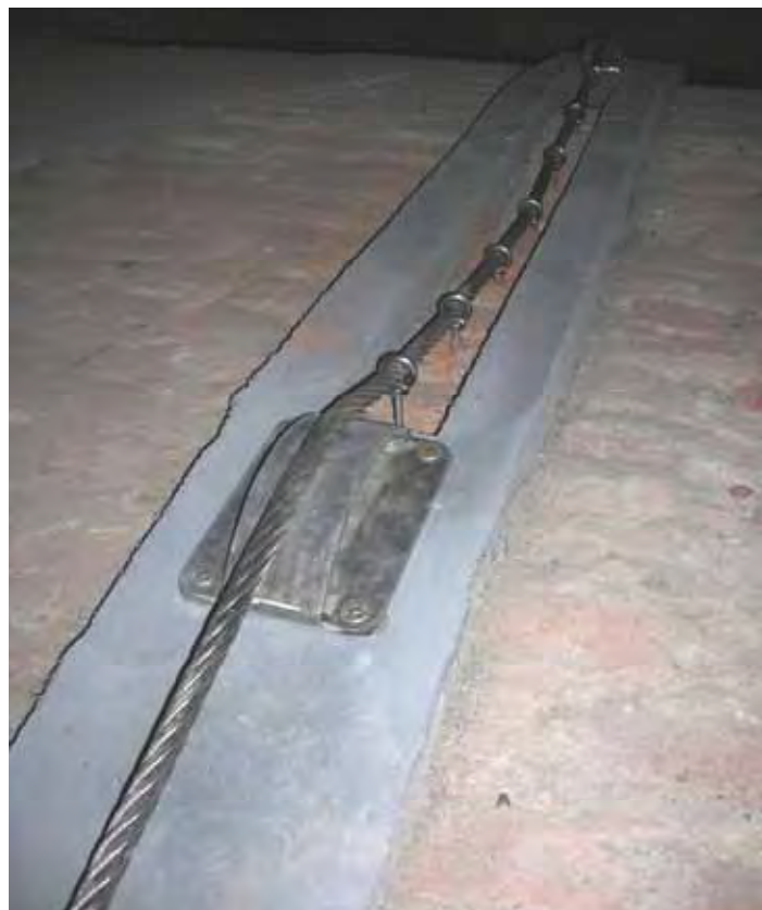
Arco armato estradossale alle volte della Galleria dei Poeti, Castello di Masino La parte centrale del cavo, in corrispondenza della depressione della volta, è stata collegata ai coni con golfari in acciaio.
