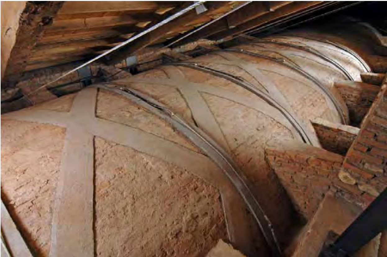
Interventi estradossali alle volte della Galleria dei Poeti, Castello di Masino Archi armati estradossali trasversali e fasciature in fibra di carbonio diagonali sulla volta a botte depressa.
