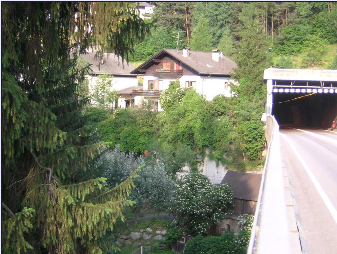
Monitoraggio casa di civile abitazione (xxxxxxxx)
