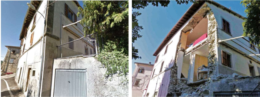
Figura 1 Accumoli: GSV (Google Street View) a sinistra e il meccanismo fuori piano a destra (tetto in legno su un anello di irrigidimento di calcestruzzo armato). Importanti e consistenti danni osservati in conformità con EMS-98 per le strutture in muratura [7].
