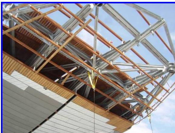
Esempio di un tiro verticale con vista dell'ancoraggio alla centina
