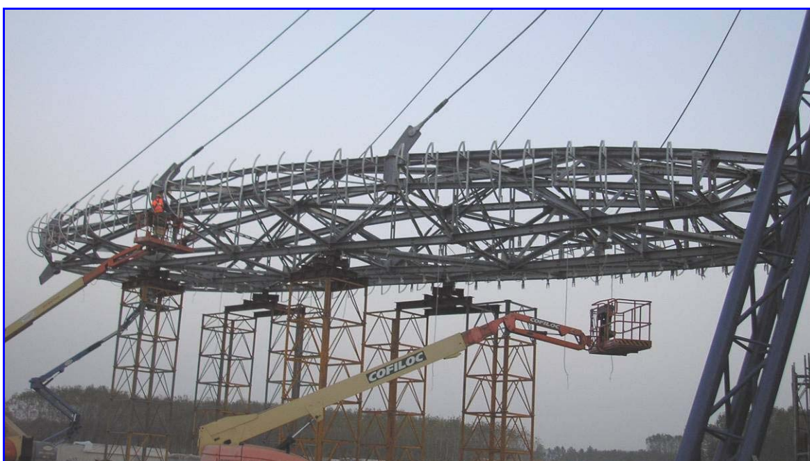
Struttura metallica Ala Est
