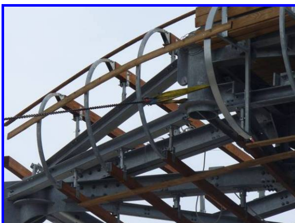
Esempio di un tiro obliquo con vista dell'ancoraggio alla centina
