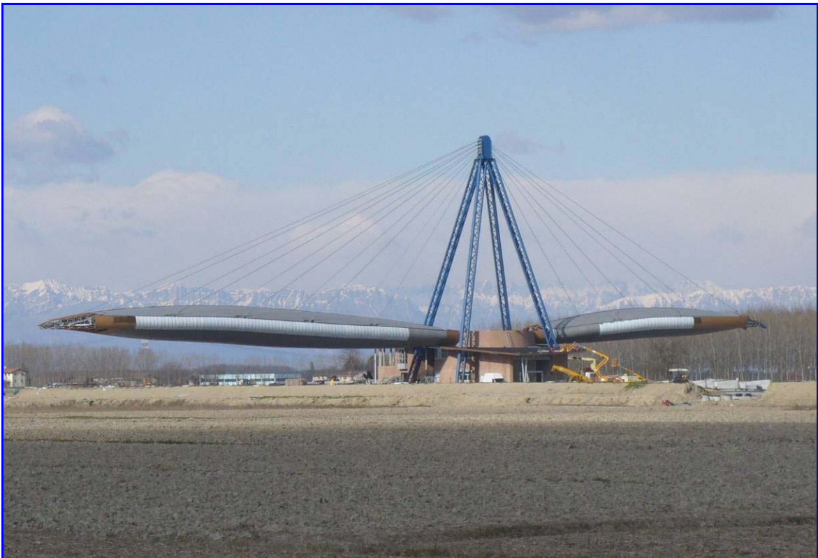
Nuovo casello autostradale di Ronchis
