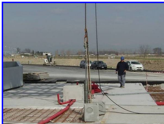
Esempio di un tiro verticale con vista dell'ancoraggio alla centina
