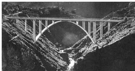
Figura 5: Il ponte sul Corace alla fine dei lavori
