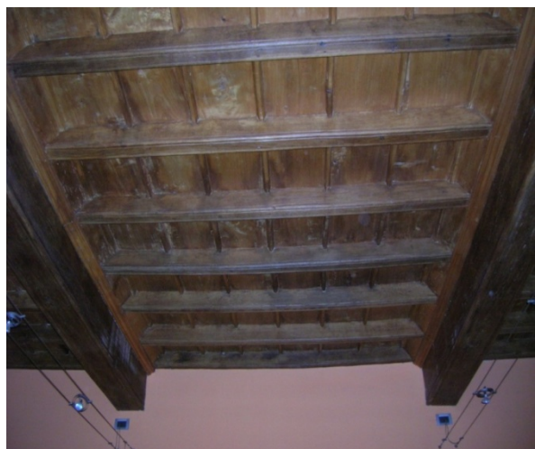
Foto 1: Solaio in legno misto
