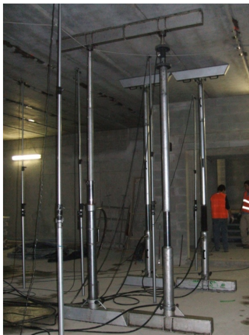
Foto 4: Pistoni idraulici di carico del solettone intermedio contrastati dal solettone superiore
