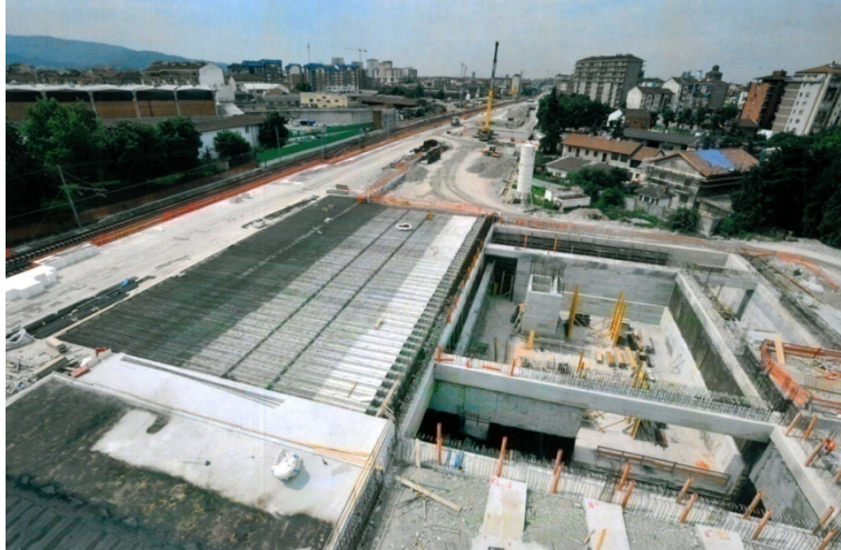
Foto 3: Complesso strutturale con solettone superiore
