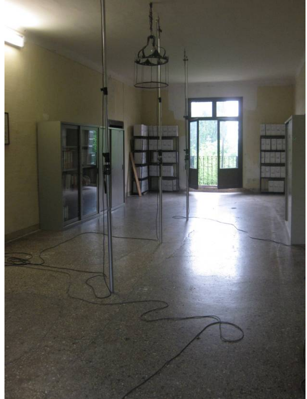
Foto 10 – Prova di carico a L+2 con comparatori puntati sotto L+2
