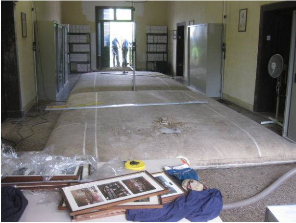
Foto 7 – Prova di carico a L+1 con comparatori puntati su L+2
