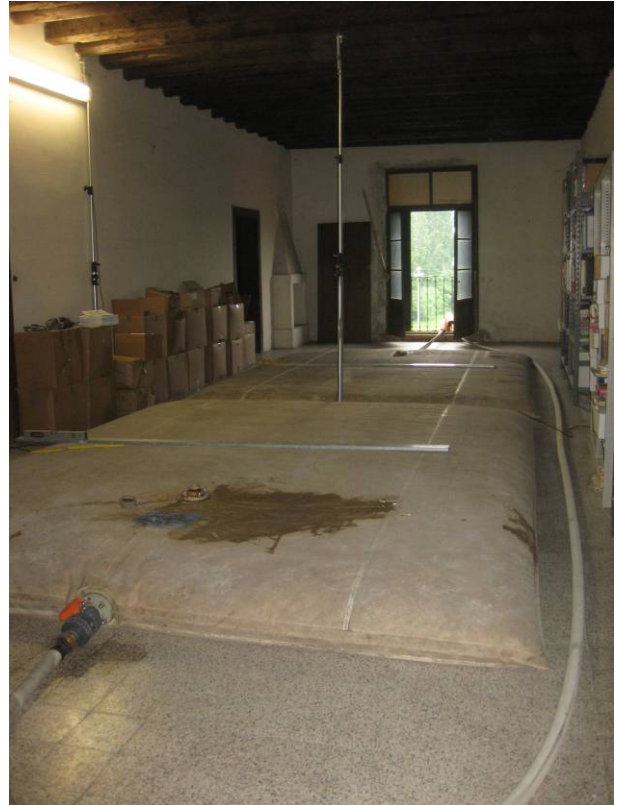
Foto 8 – Prova di carico a L+2 con comparatori puntati su L+3
