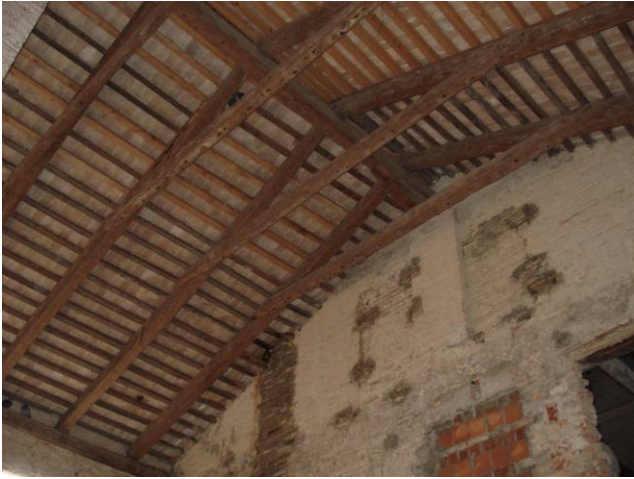
Foto 5 – Tetto barchessa ante intervento
