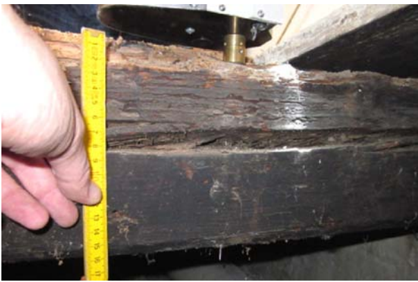
Foto 13 – Test Resistograph su trave fratturata
