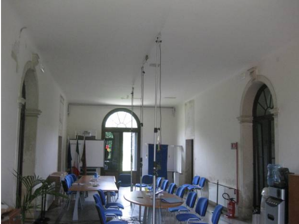
Foto 9 – Prova di carico a L+1 con comparatori puntati sotto L+1 per verificare comportamento controsoffitto
