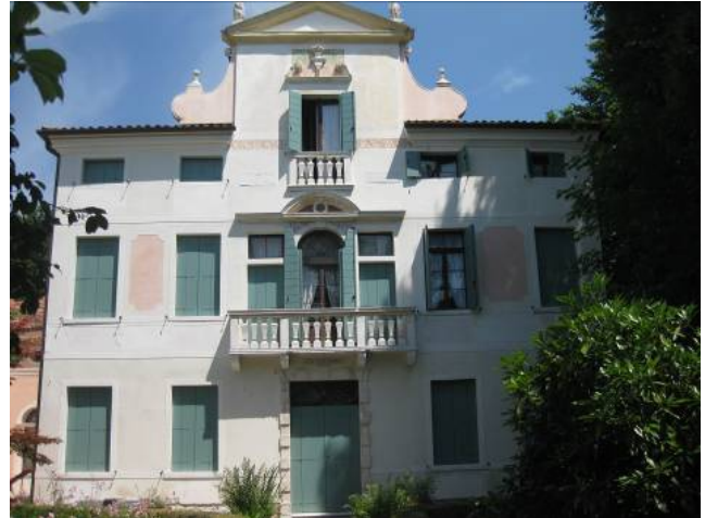
Foto 2 – Villa post intervento
