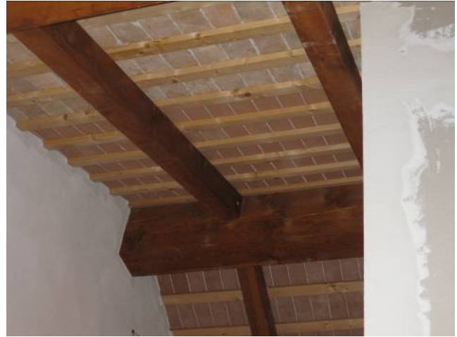
Foto 6 – Tetto barchessa post intervento
