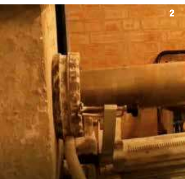
2. Esecuzione di una carota su pilastro
