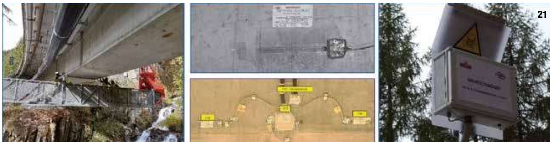
21. Fasi di installazione di un monitoraggio estensimetrico
