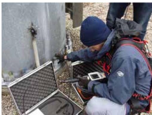
Verifica tirafondi con videoendoscopio
