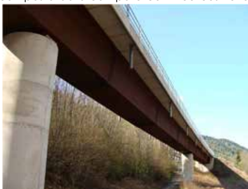
Vista del ponte
