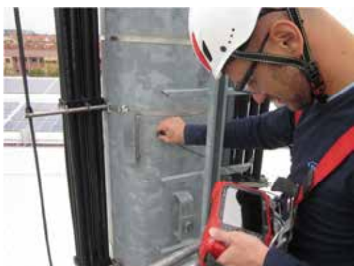
Pali porta antenna e tori faro
