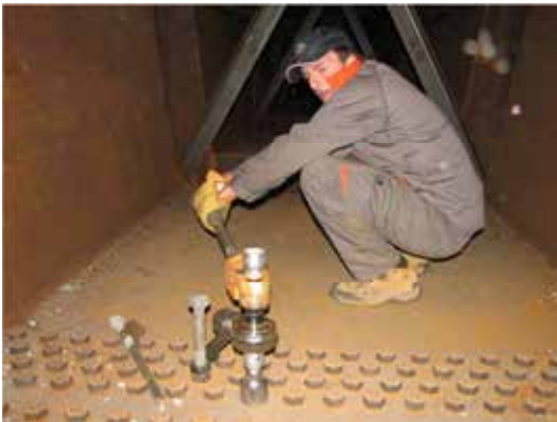
Verifica della coppia di serraggio
