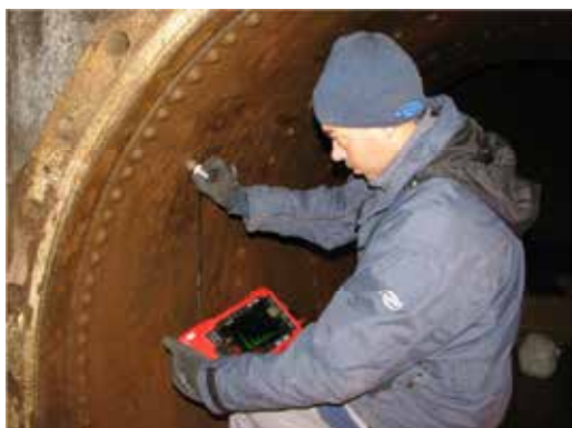
Tubazioni e serbatoi
