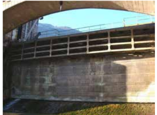
Vista della paratoia
