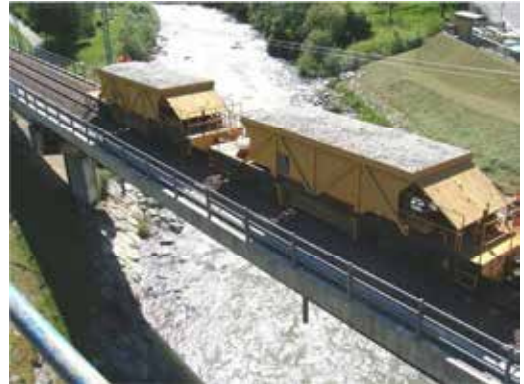
Prova di carico
