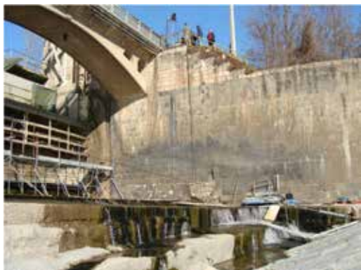
Prova di carico a tiro con martinetto oleodinamico e misura delle deformazioni
