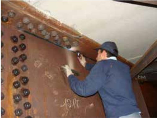
Controllo visivo saldature
