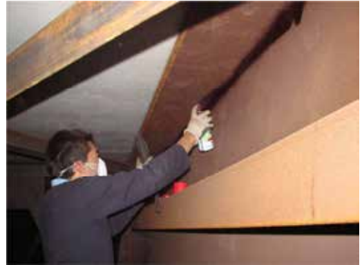
Controllo con liquidi penetranti saldature
