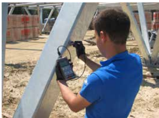
Misura dello spessore della zincatura
