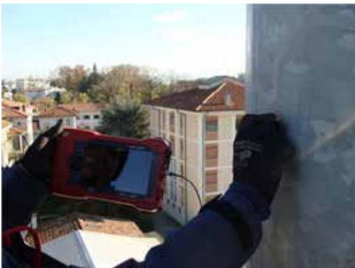
Misura dello spessore con ultrasuoni
