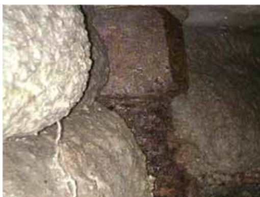
Controllo corrosione dei tirafondi di un palo porta antenna
