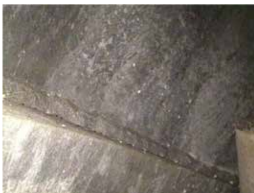
Controllo saldatura interna alla base di un palo porta antenna
