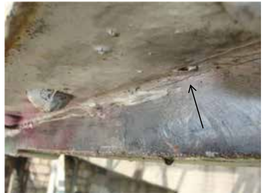
Cricche longitudinali su cordoni di saldatura
