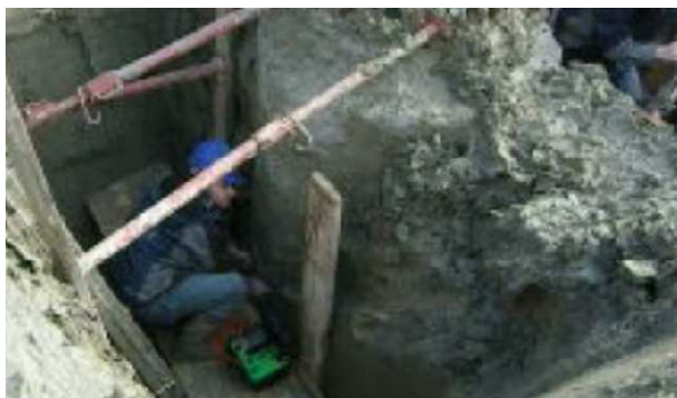
Fig.9.4.2 – Preparazione delle superfici
