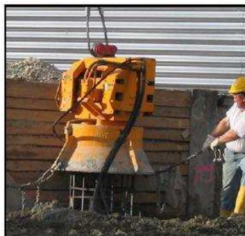
Fig. 4.4.2 – Unità vibrante posta in testa
