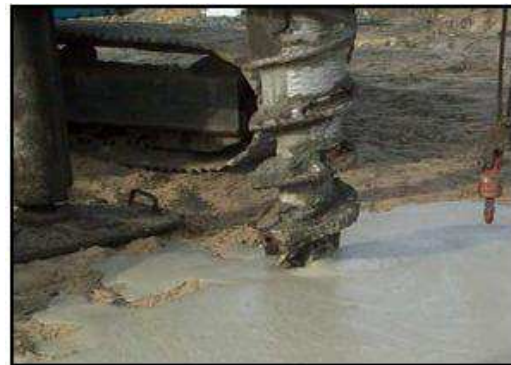
Fig 4.3.2.3 – Difficoltà nel trovare la parte finale del palo alla fine dell'operazione di getto
