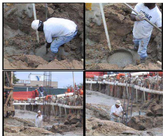
Fig. 4.3.2.4 – prime due foto pulizia della parte superiore del palo, ultime due foto fasi iniziali di inserimento armatura
