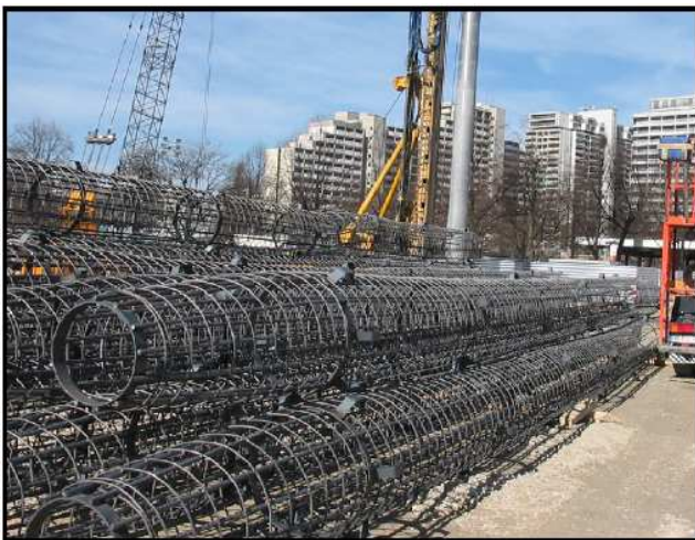
Fig. 5.7.2.2.2 – Gabbie d'armatura pronte per la posa
