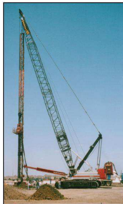
Fig. 5.2.2 – Foto macchina perforatrice con elica montata su una gru
