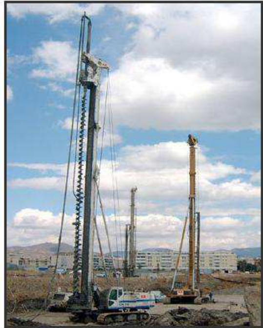
Fig. 5.2.4 – Foto perforatrice idraulica con Kelly bar
