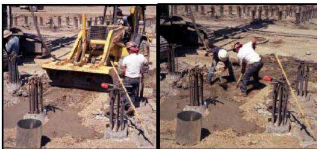
Fig. 5.6.1 – Rimozione del terreno mediante pala meccanica e manualmente, posizionamento del modulo in acciaio
