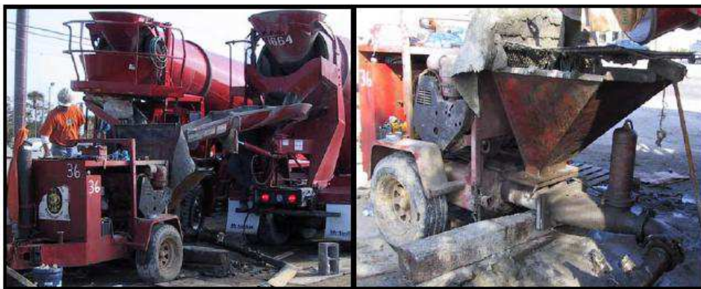
Fig.5.5.1 – Autobetoniera che scarica il calcestruzzo nella pompa e dettaglio della pompa
