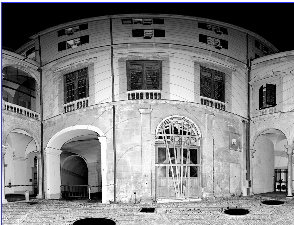
Scansione in risoluzione 1/2, prospetto nord, stazione S 4 , rilievo del 21 ottobre 2009
