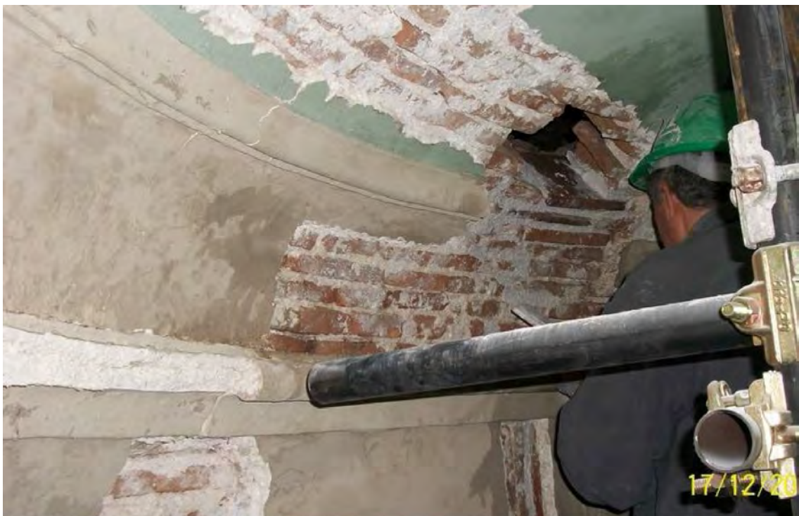
Fig. 8 - Particolare di fig. 6: rifacimento a scuci e cuci della volta, operando dall'interno senza centina.
