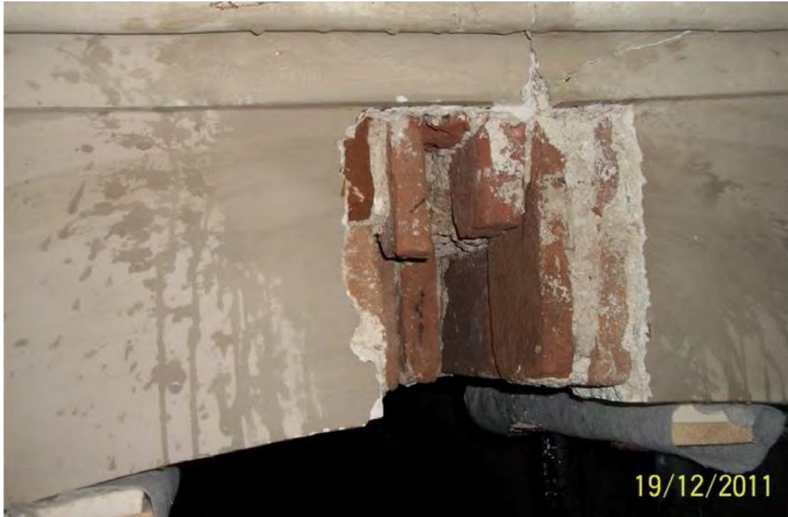
Fig. 7 - Particolare di fig. 6: scucitura dell'arco in chiave.
