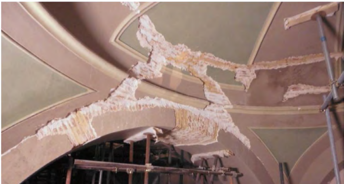
Fig. 6 - La volta di fig. 5 riparata a scuci e cucì (Chiesa di S. Biagio Amiternum, L'Aquila)
