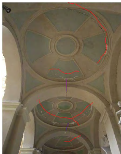
Fig. 5 - Scorrimento lungo i giunti per sisma
