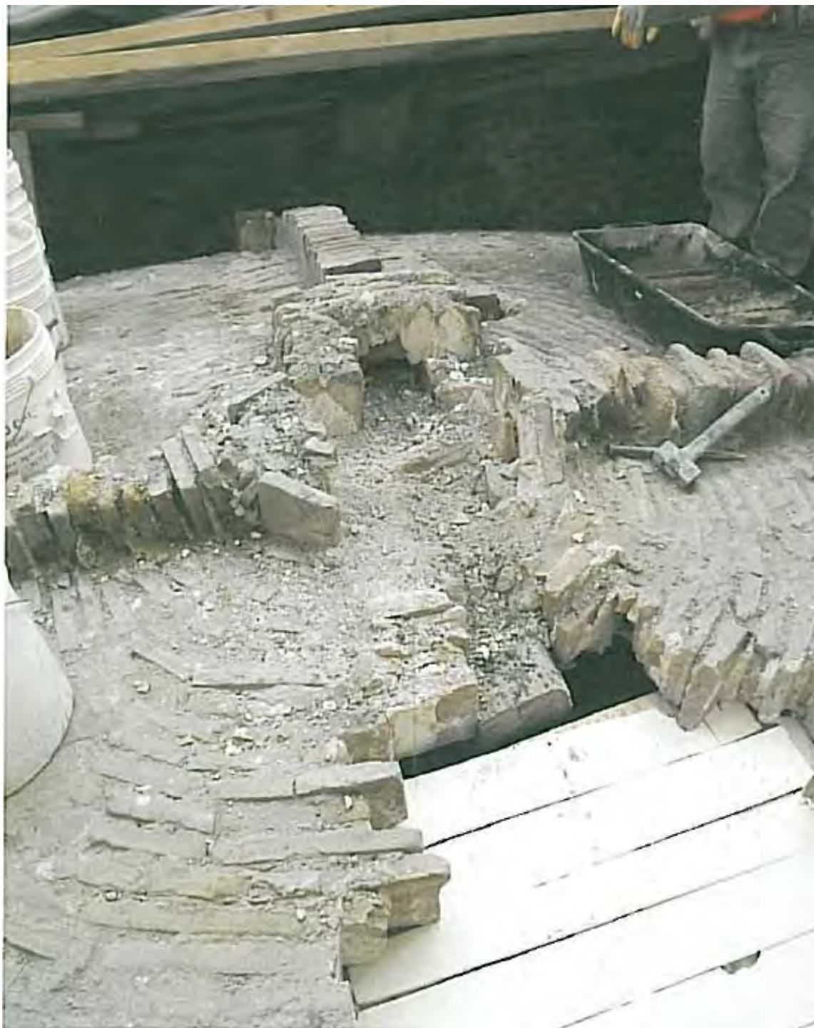
Fig. 9 - Rifacimento a scuci e cuci dall'estradosso con l'ausilio di centina.
