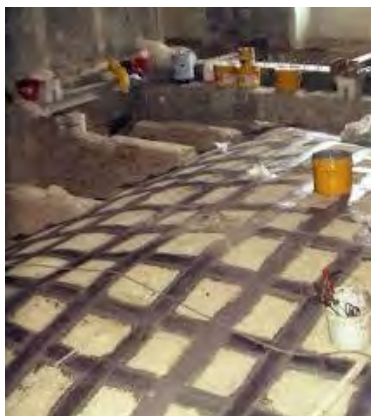
Fig. 24 - Rinforsamento estradossale di volta a botte.
