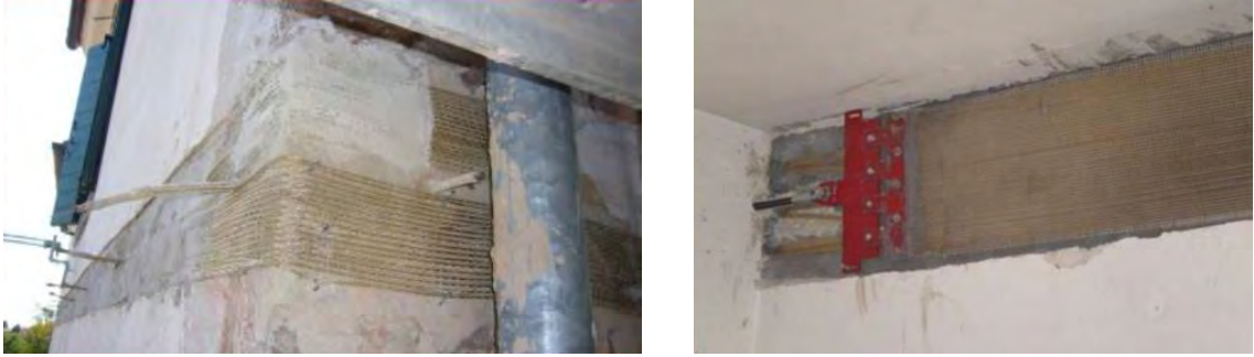
Fig. 21 e 22- Costruzione di tiranti in fibre applicati all'esterno ed all'interno.
