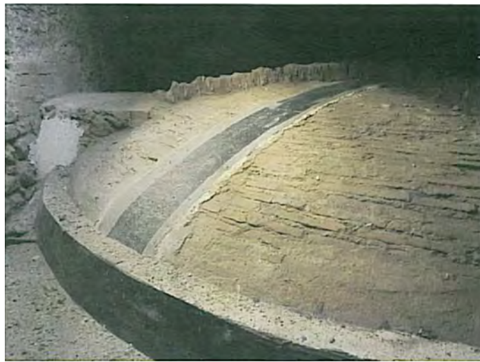
Fig. 20 - Anello di cerchiatura in fibra di carbonio alla base di una cupola (Chiesa di S. Biagio Amiternum, L'Aquila). E' presente anche un rinforzo estradossale diametrale.
