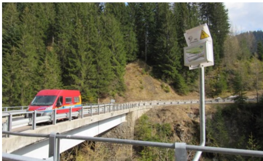
Fig. 6 Centralina di trasmissione dati - fotovoltaica.
