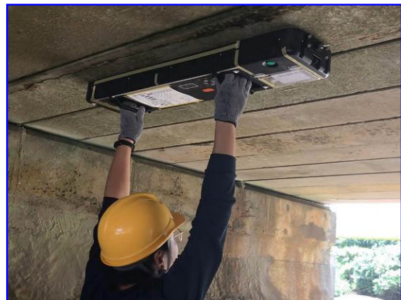
Figura 11: scansione con Senriqan su travi in c.a.p.
