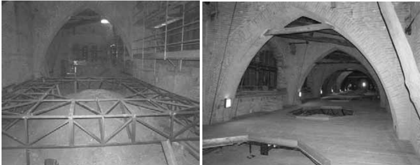
Figura 8: Realizzazione delle travi reticolari e successiva copertura con tavolato ligneo.
