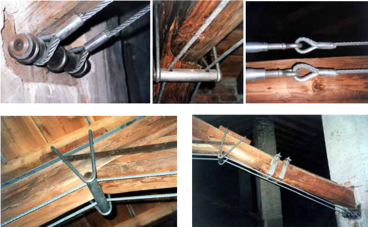
Figura 2 a, b, c, d, e. Dettagli dell'intervento di consolidamento con utilizzo di un cavo sagomato post tesato, in posizione intradossale, per consolidare i puntoni a sbalzo, fortemente inflessi
