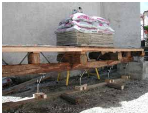
Figura 9. Prove di carico: prima fase di carico sulla parte centrale (fino a P=1300 kg), a scarico ultimato non si osservano danneggiamenti.
