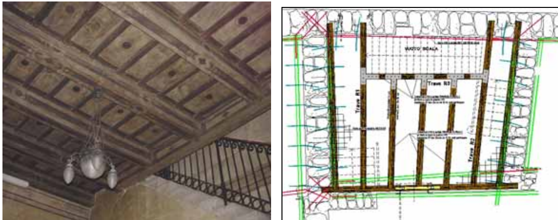
Figura II. 45. a, b. Solaio della stanza del consiglio.
