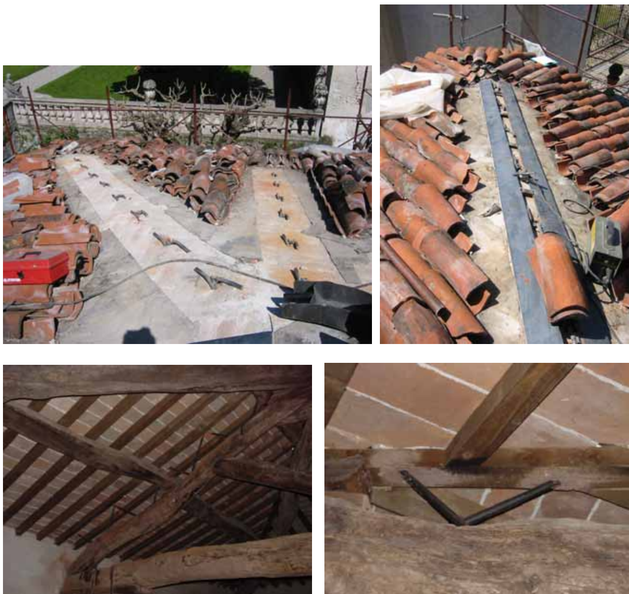
Figura 7 a, b, c, d. Dettagli di realizzazione dell' intervento in copertura
