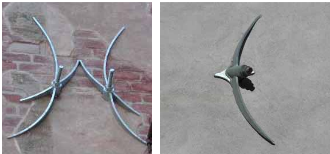
Figura II. 24 a, b. Capochiave realizzato
