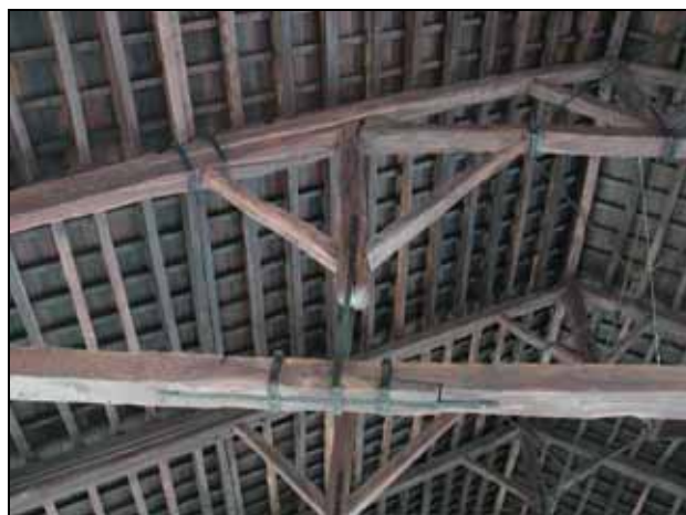
Figura 26 a,b. Immagini della copertura dall'intradosso.
