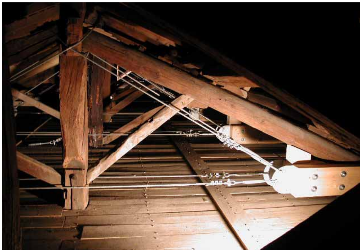
Figura 19. Realizzazione del consolidamento mediante cavi esterni post tesati e "bilancini" in legno lamellare appoggiati sulla muratura.
