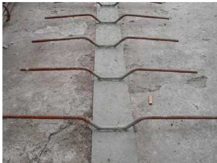
Figura II. 5 Connetto rmetallici sagomati a "manubrio"
