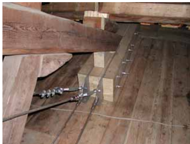
Figura 20 a, b. Particolari dell'intervento di consolidamento realizzato
