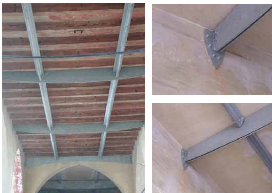
Figura II. 19 a, b, c. Dettagli del graticcio costituito da nuove travi metalliche.
