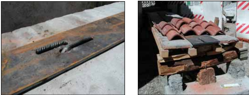
Figura 8. Prove di carico. a) Saldatura dei diagonali \phi 20 mm alla piastra metallica posta in sommità. b) Il sistema di rinforzo secondo la configurazione finale di intervento
