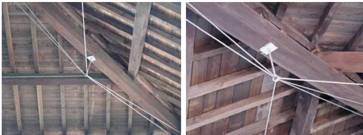
Figura 16. La copertura a struttura reticolare realizzata.
