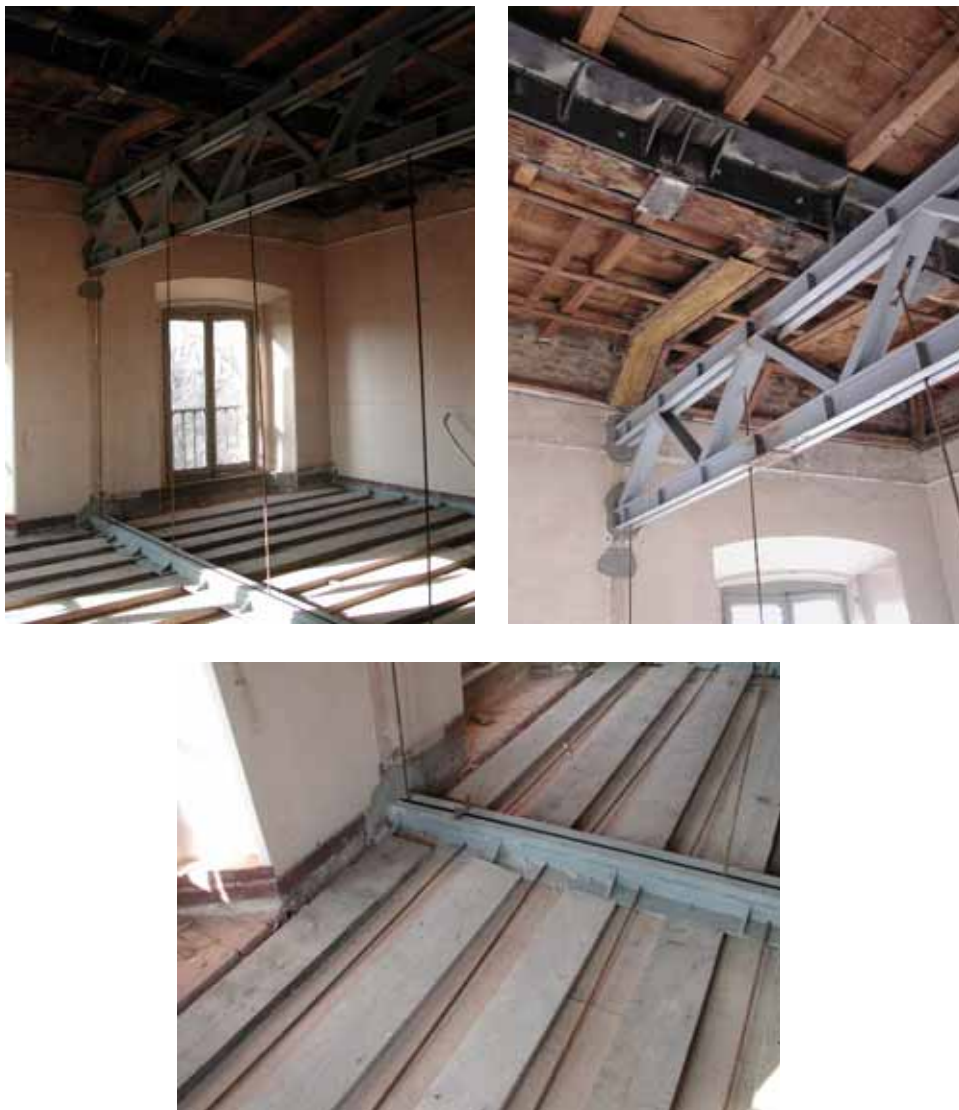
Figura II. 3 a,b,c. Immagini durante la fase di realizzazione dell'intervento.
