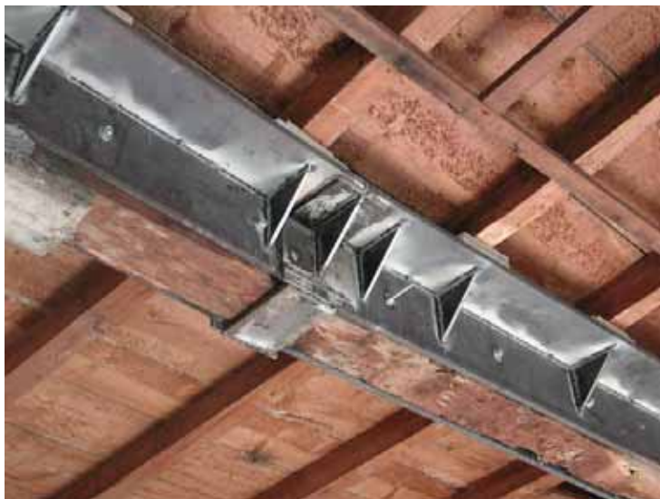
Figura II. 7. Il rinforzo delle travi spezzate in mezzeria mediante affianco di coppia di profilati ad L.
