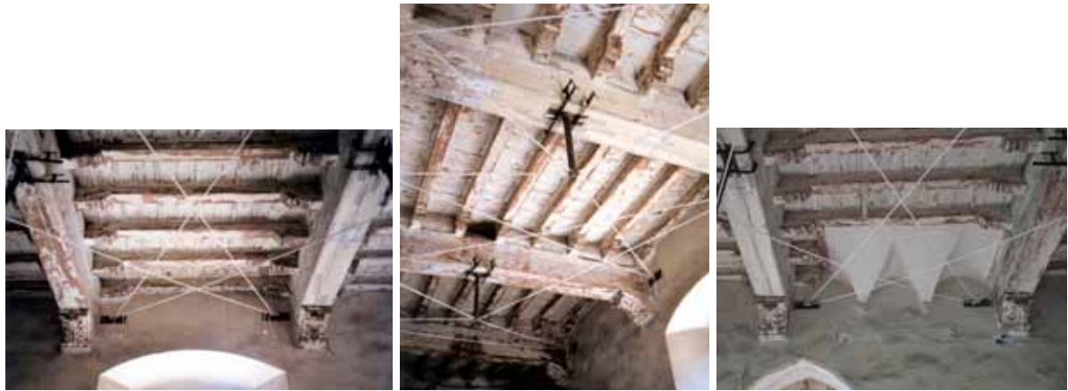
Figura II. 22 a, b, c. Modello realizzato in scala reale in situ per la messa in opera del rinforzo di solaio ligneo con struttura reticolare in trifolium di acciaio: dettaglio dell'attacco alla parete e i puntoni telescopici
