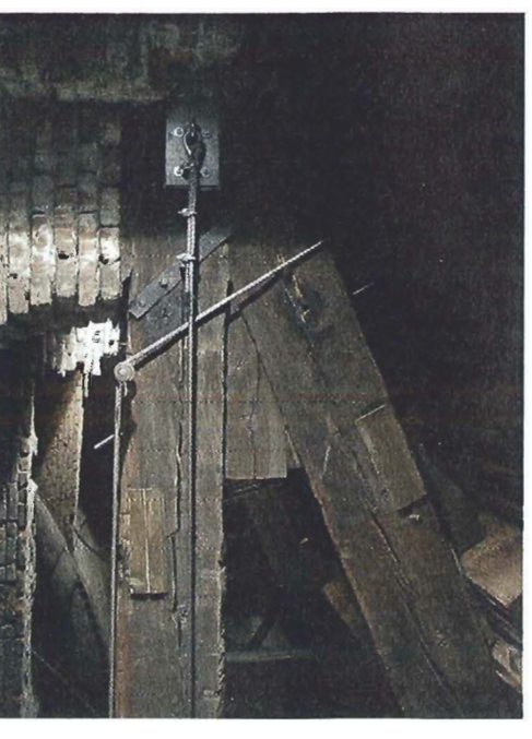
Figura 15 - Base della capriata, dove il cavo dopo essere passato sotto alla catena, risale e scavalca il puntone
