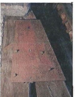
Figura 3 - Una delle cuffie metalliche poste negli anni '50 per rinforzare i nodi delle capriate
