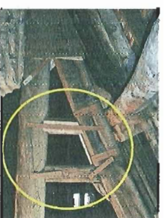
Figura 4 - Puntelli inseriti tra puntone e catena per aiutare i puntoni inflessi
