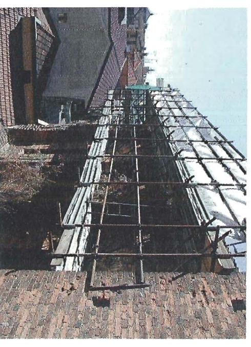
Figura 20 - Corona di ponteggi
