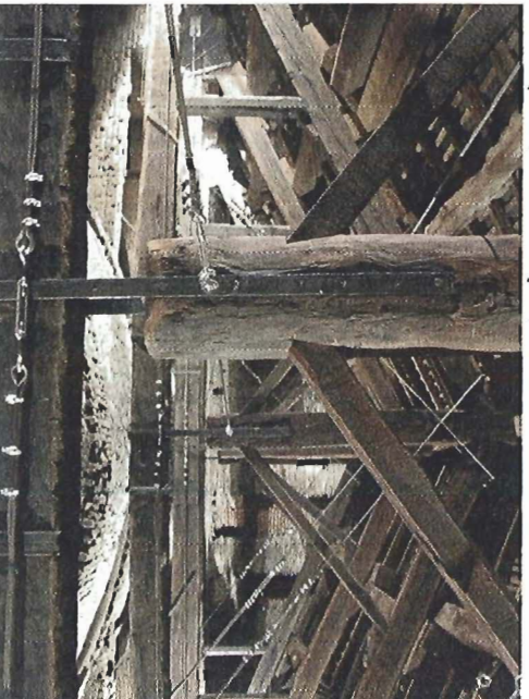
Figura 17 - Tirante teso lungo l'asse della chiesa "inanellando" tutti i monaci delle capriate
