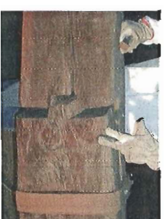
Figura 6 - Fuori-piombo dei monaci con deformazioni delle staffe di collegamento alle catene
