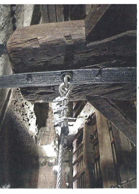
Figura 15 - Base della capriata, dove il cavo dopo essere passato sotto alla catena, risale e scavalca il puntone
