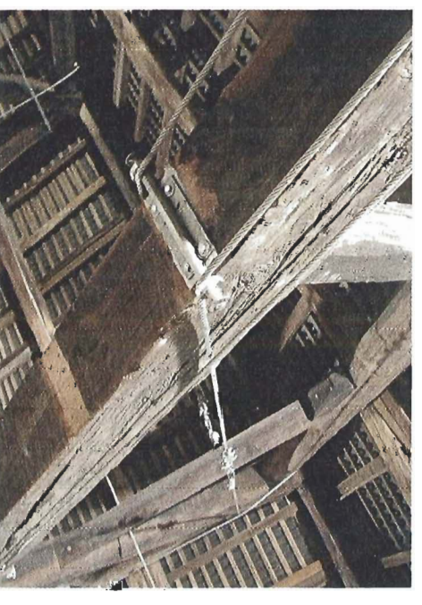
Figura 12 - Elementi ripartitori in acciaio
