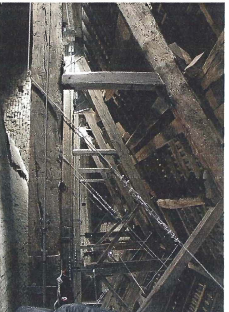
Figura 11 - Intervento di consolidamento delle capriate
