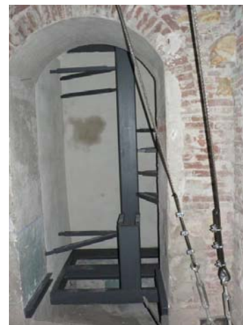
Figura 24. Scala interna al campanile, in fase di realizzazione
