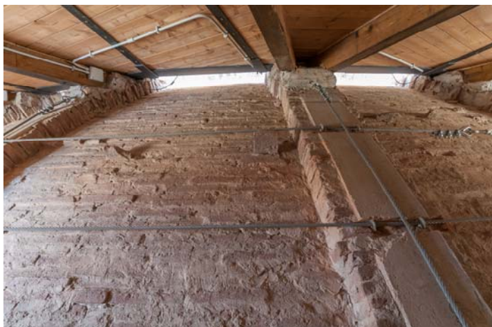
Figura 23. Intervento di rinforzo della cupola ellittica con trefoli di cerchiatura paralleli e trefoli meridiani sulle costole
