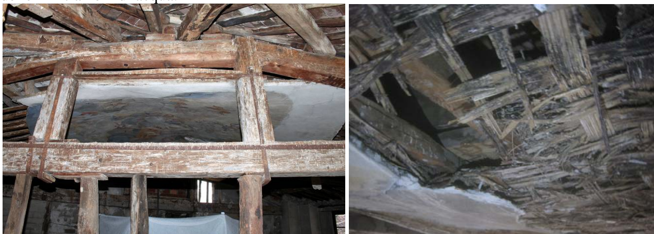
Figura 7. Affresco della Gloria di Santa Caterina , di Lorenzo Castellotti, fissato su supporto incanniccio alla struttura lignea di copertura, prima degli interventi di restauro
