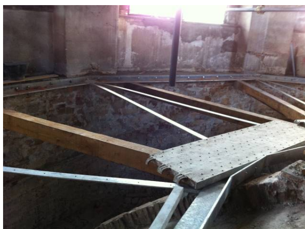
Figura 9. Solaio di sottotetto. Integrazione delle travi lignee, prima della posa dell'assito triplo
