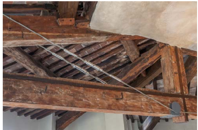
Figura 16. Particolare degli interventi di rinforzo della prima capriata (A) con tralci in acciaio sagomati
