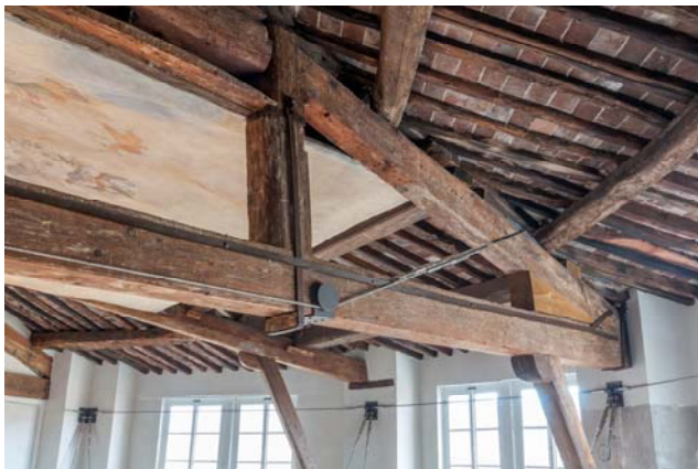
Figura 15. Particolare degli interventi di rinforzo della prima capriata (A) con puntelli lignei e tralci in acciaio sagomati.
