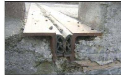
Profilato elastomerico tra angolari in metallo
