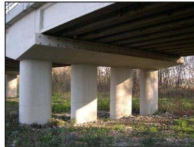
Pila a più colonne in calcestruzzo
