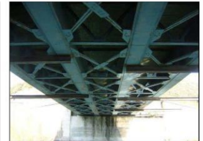
Travi e traversi in acciaio con irrigidimenti
