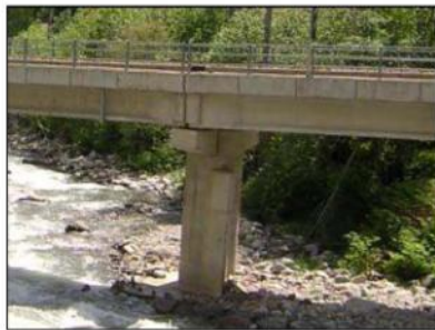
Pila a colonna in calcestruzzo
