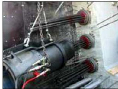
Tesatura dei cavi di precompressione
