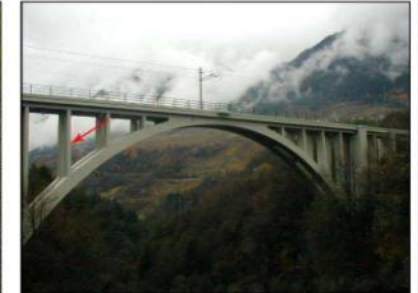
Piedritti di un ponte ad arco inferiore
