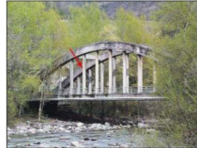
Piedritti di un ponte ad arco superiore
