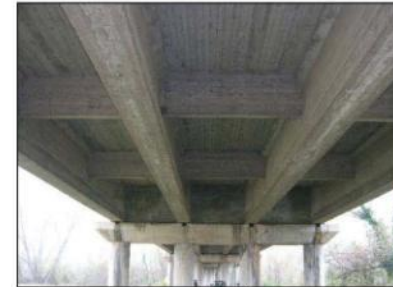
Travi e traversi in calcestruzzo
