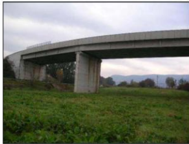
Pila a setto in calcestruzzo
