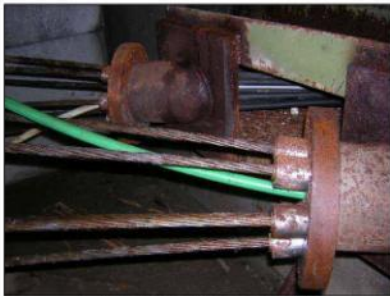
Testate dei cavi di precompressione
