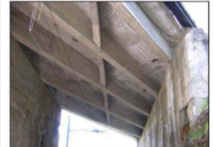
Travi e traversi in calcestruzzo
