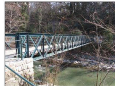
Trave reticolare in acciaio
