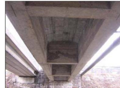
Travi e traversi in calcestruzzo
