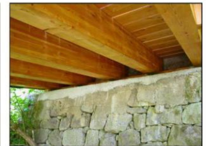
Travi in legno
