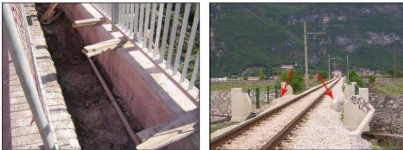
Cordolo lungo i bordi dell'impalcato
