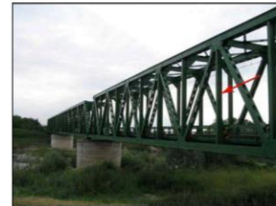
Piedritti di un ponte a struttura reticolare in acciaio
