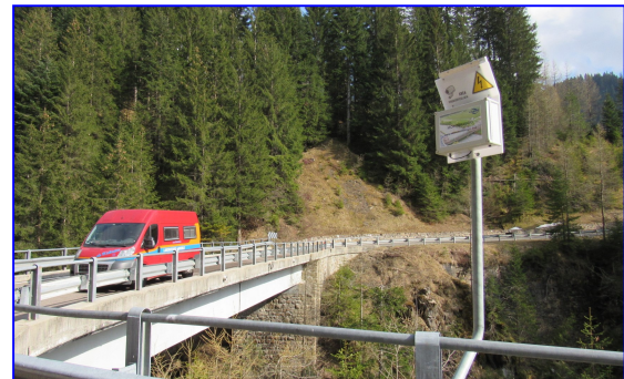
Fig. 7 Centralina di trasmissione dati - fotovoltaica
