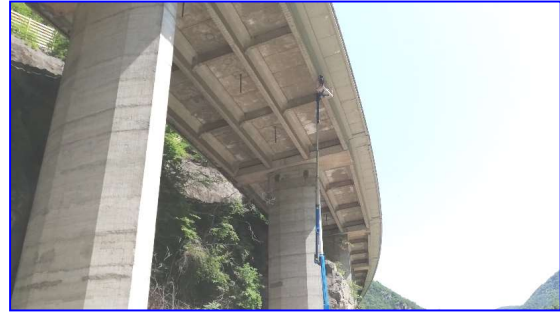
Fig. 2 Impalcato con struttura a travi precomprese
