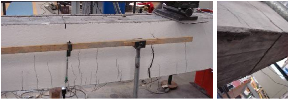
Figura 8 : Tests a flessione , Trave rinforzata: distribuzione delle fessure (sinistra) e macro-fessura (destra) vista dall'intradosso della trave.
