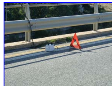
1/2 luce lato sud
