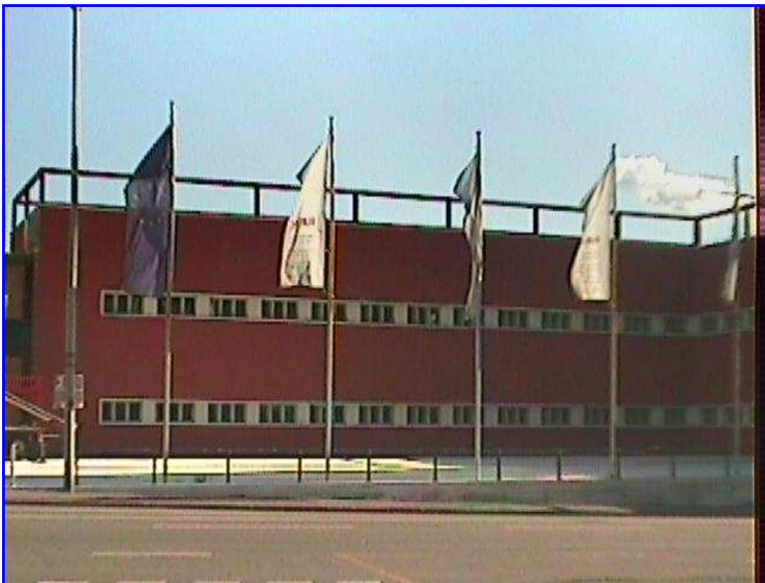
Edificio sede XXXXXXXXXXXX
