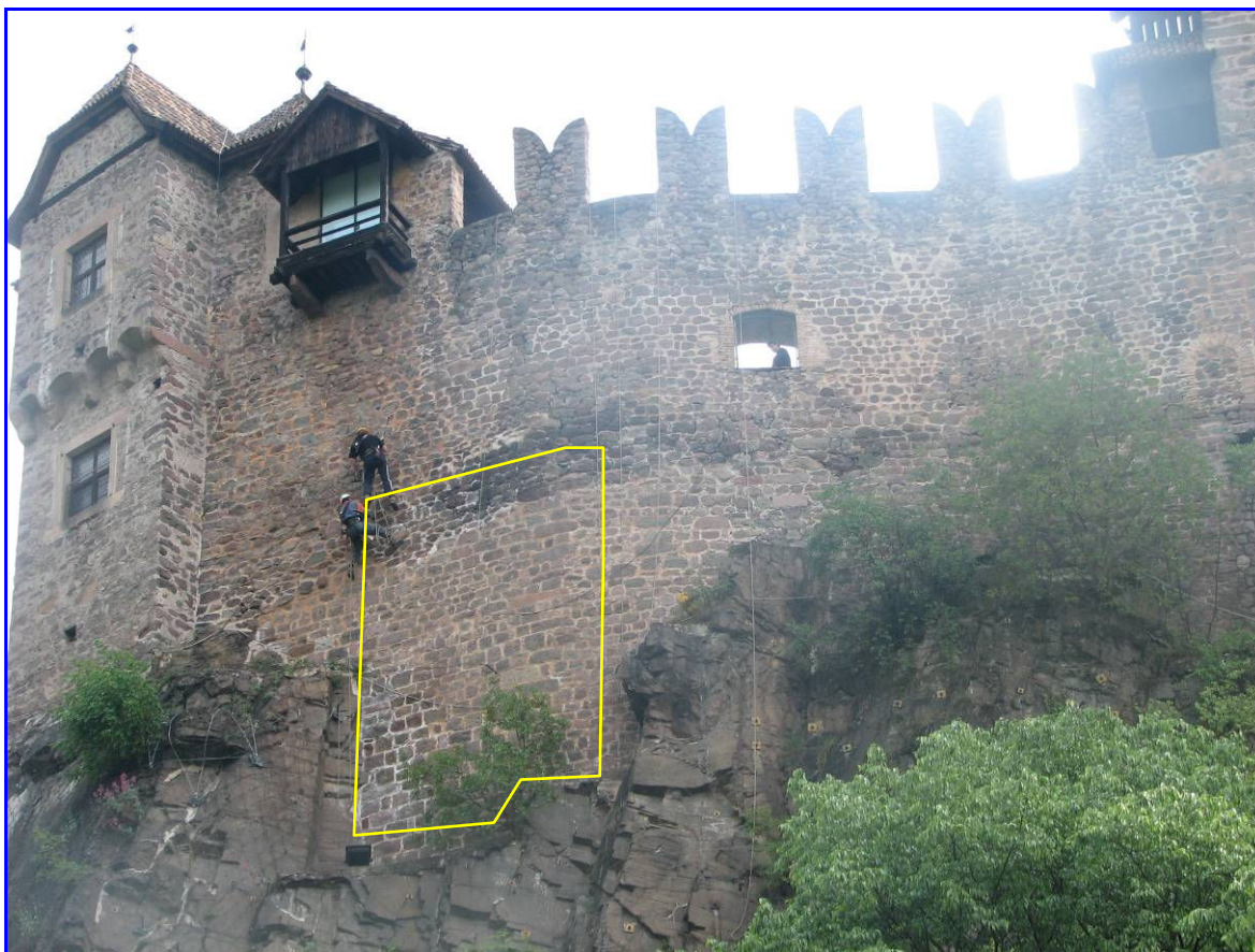
Porzione di muratura indagata
