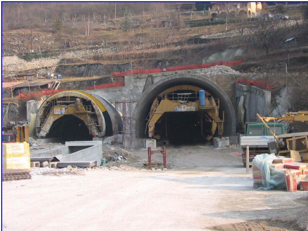
Imbocco lato ovest delle gallerie
