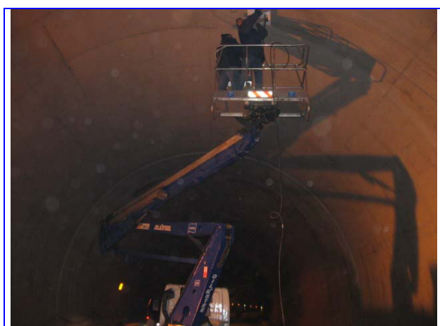
Foto 1: Rilievo della sezione trasversale
