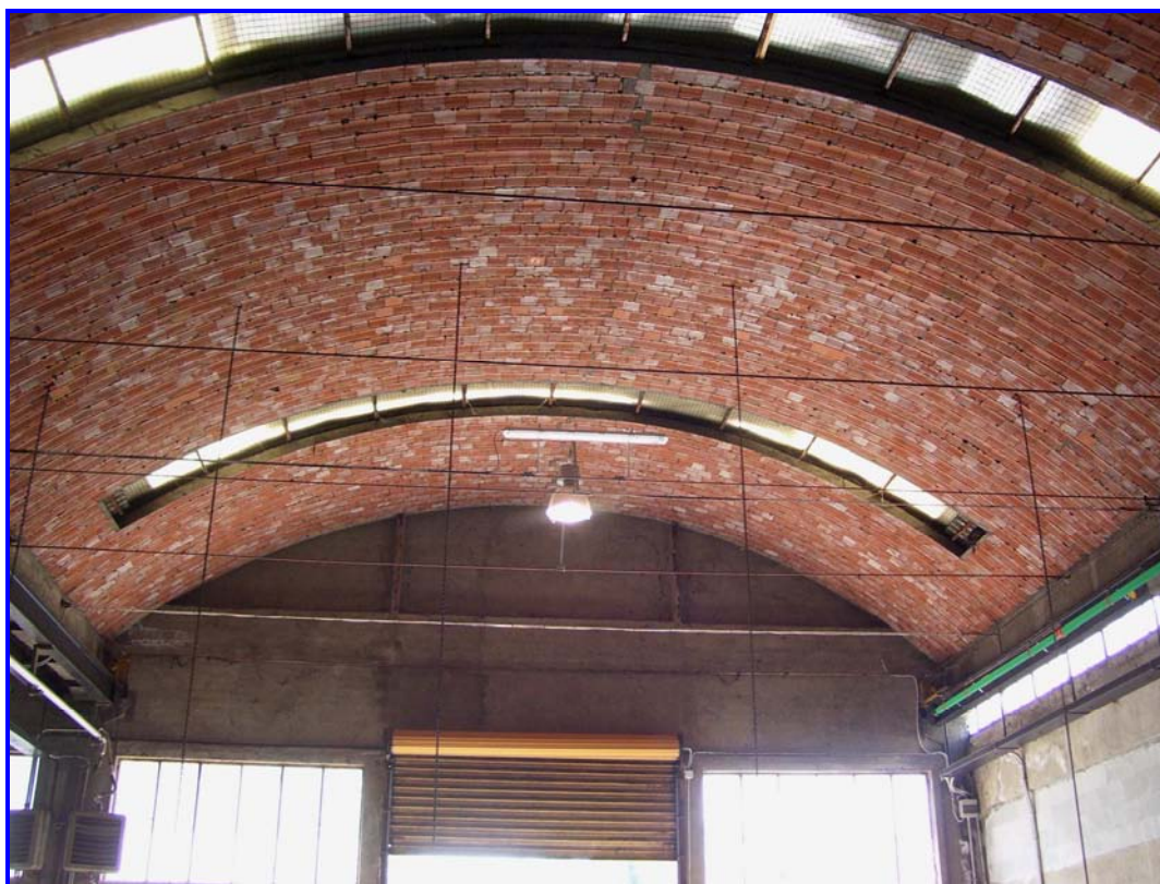
Le cinque catene all'intradosso del solaio provato
