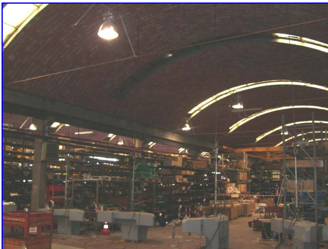
La zona di solaio caricata
