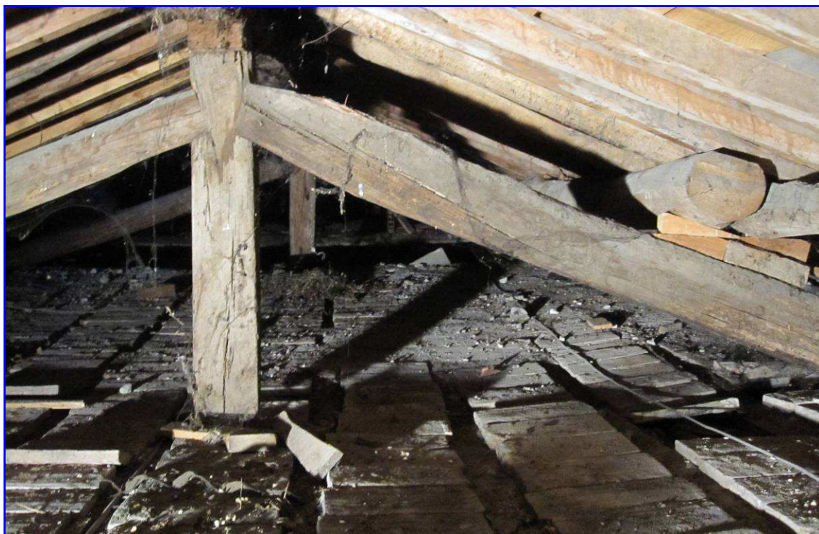
Foto 22: Solaio zona nord-ovest
