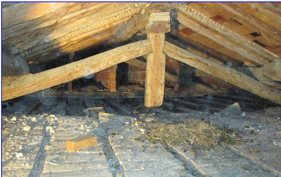
Foto 23: Solaio zona nord-ovest
