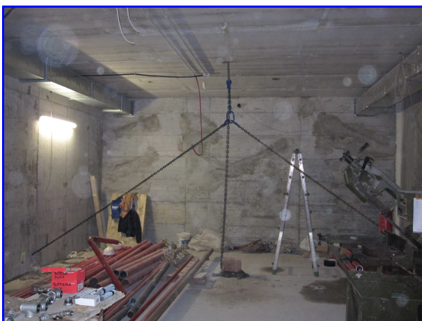
Foto 3: Metodo d'ancoraggio ai muri portanti sottostanti mediante catena e basi
