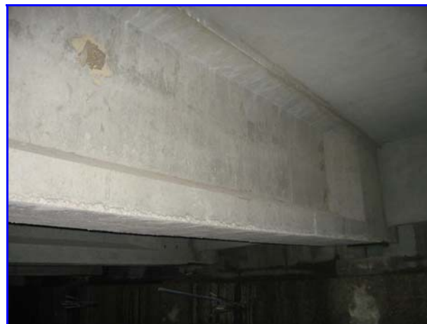
Foto 2: Testa di una delle travi indagate in corrispondenza della spalla sud
