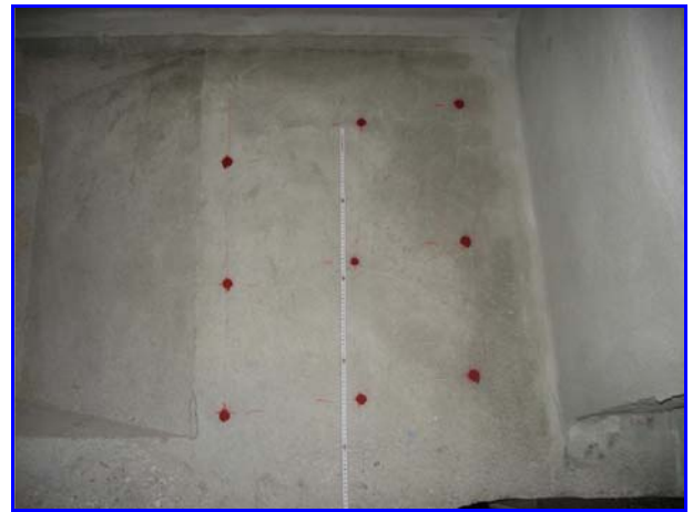
Foto 16: Testa sud, trave G, campata 3 (1597)
