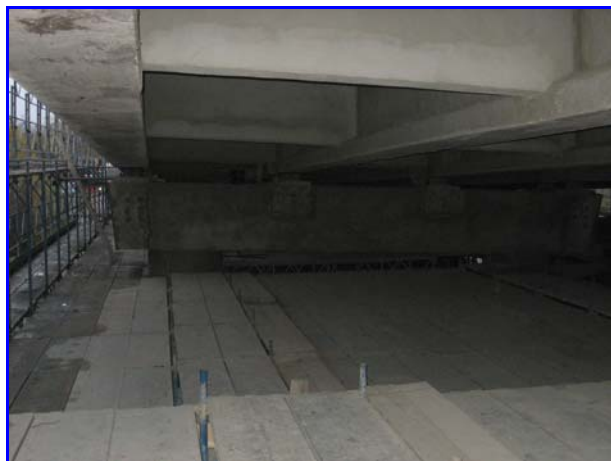
Foto 1: Vista dell'intradosso dell'impalcato dalla spalla sud
