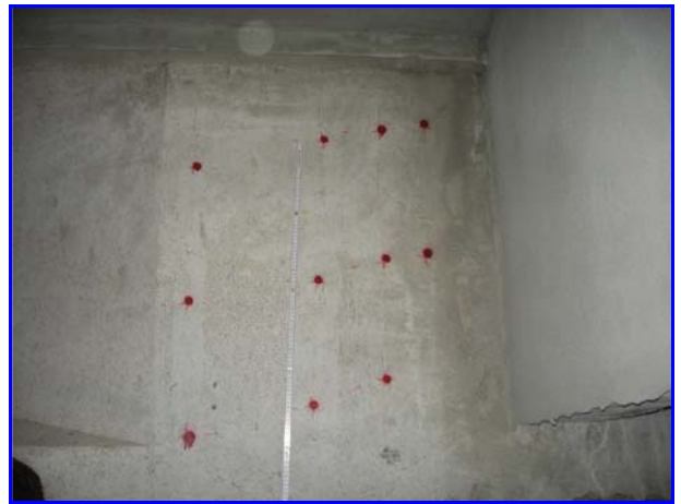
Foto 10: Testa sud, trave A, campata 2 (1601)
