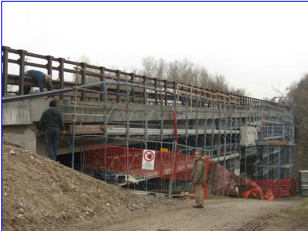
Panoramica del cantiere del ponte XXXXXXXX
