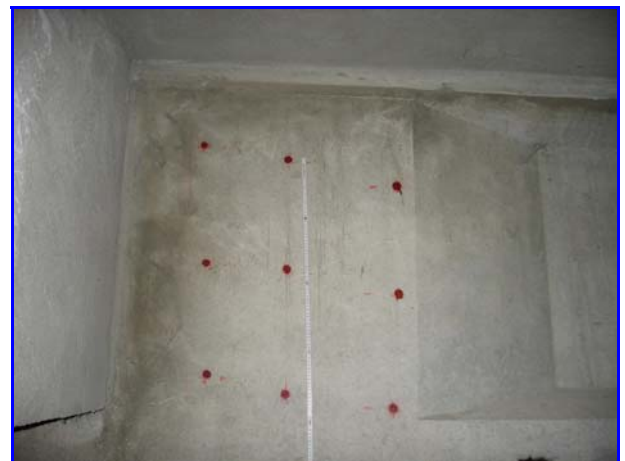
Foto 6: Testa sud, trave G, campata 1 (1607)
