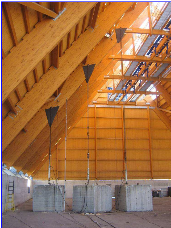
Particolare del sistema di tiro e ancoraggio martinetti
