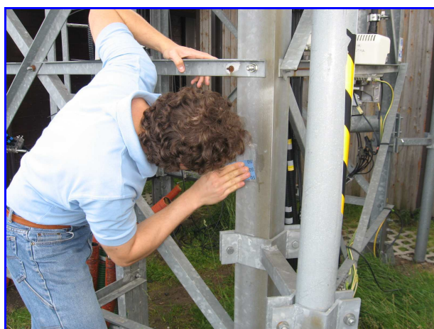
Foto 2: Preparazione della zona di prova
