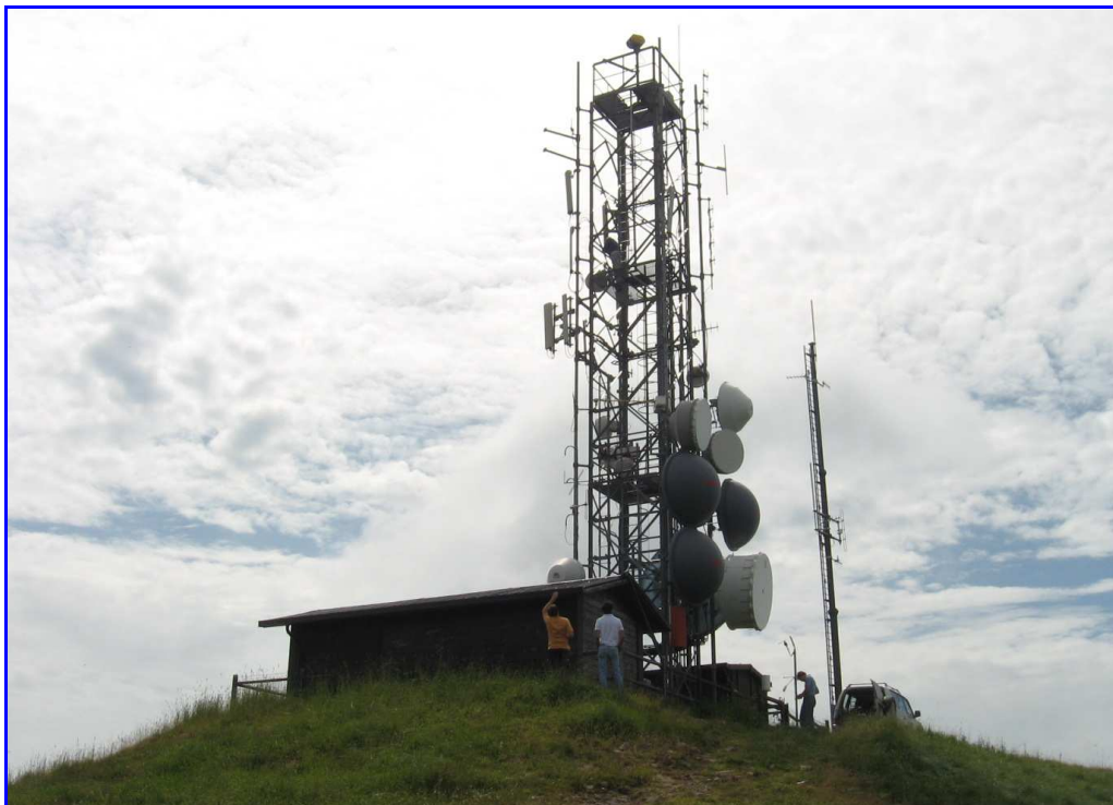
Traliccio metallico porta antenne oggetto d'indagine
