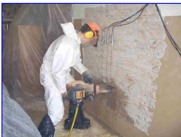
Foto 19: Esecuzione del taglio
