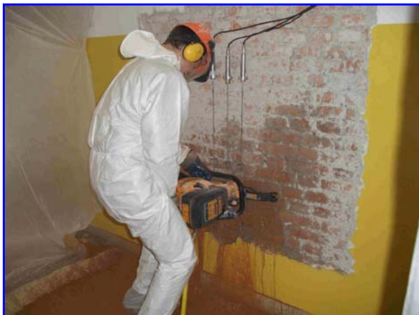
Foto 15: Esecuzione del taglio
