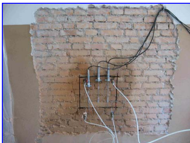
Foto 21: Rilievo tensione rottura
