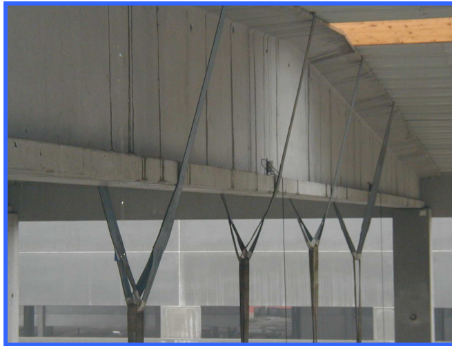
ancoraggio superiore con fasce
