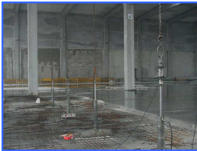
ancoraggio inferiore con tasselli meccanici
