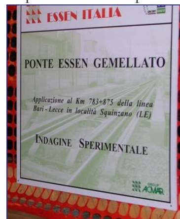
Foto 1 Cartello di cantiere
