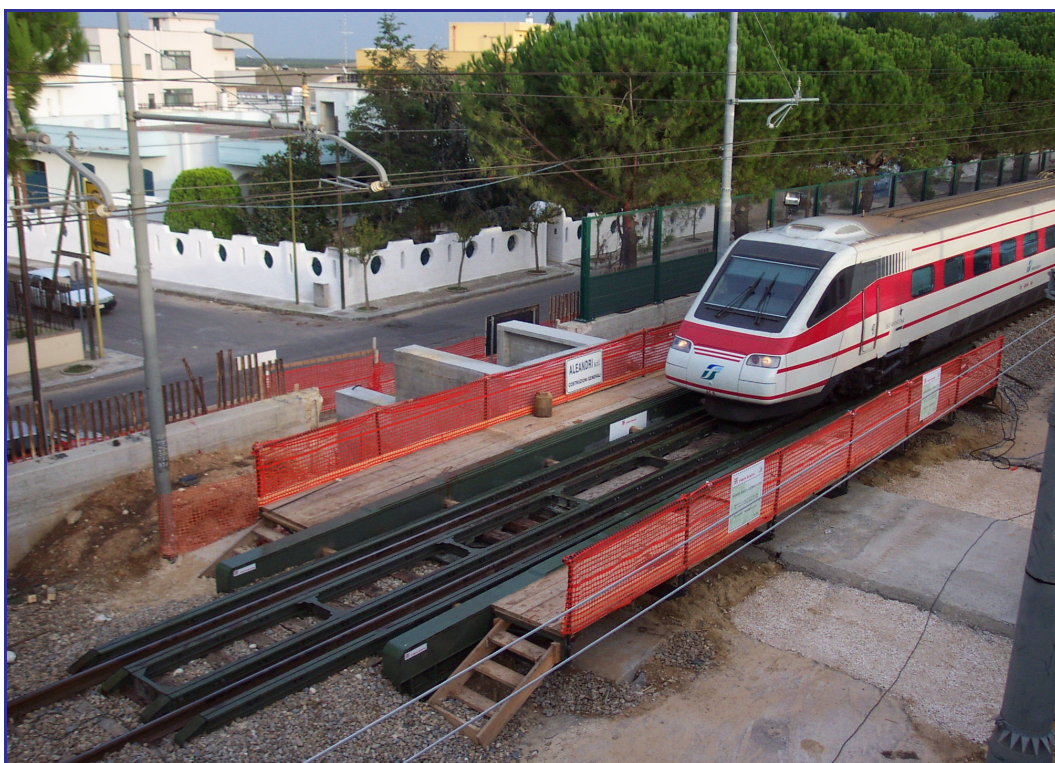
Ponte Essen Gemellato
