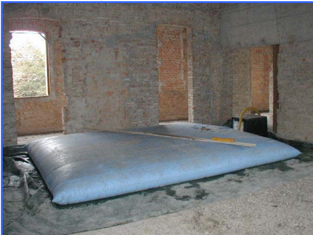
posizionamento serbatoio – carico massimo
