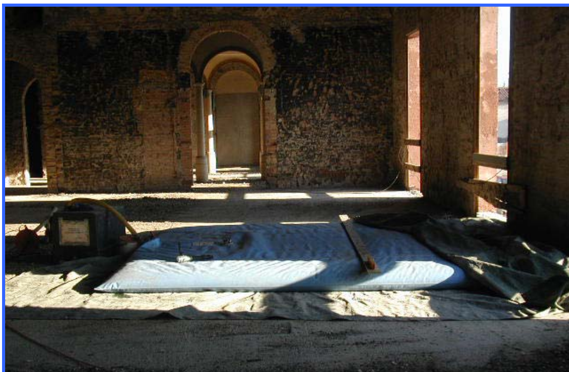
posizionamento serbatoio – fase di scarico
