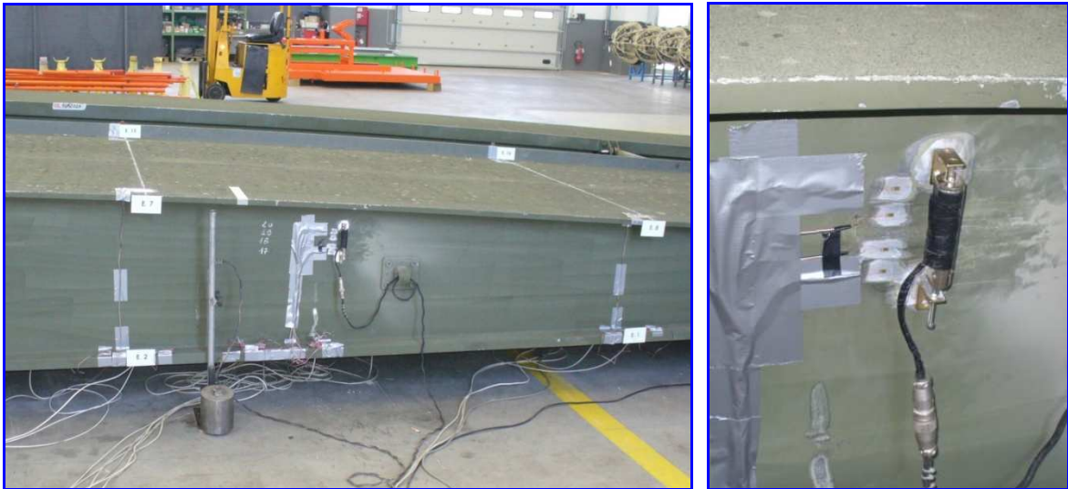
Moncione 4 - Cricca 1 (Particolare 1) - Sensore Se.10
