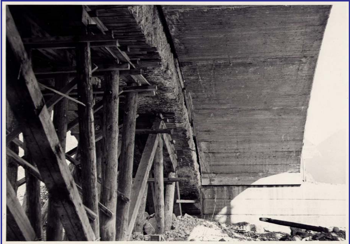
Struttura originaria usata come cassaforma
