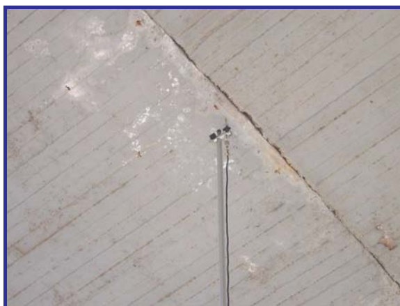
Trasduttore in mezzeria II campata
