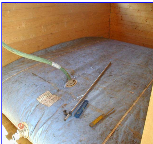
Foto 5 : applicazione del carico
