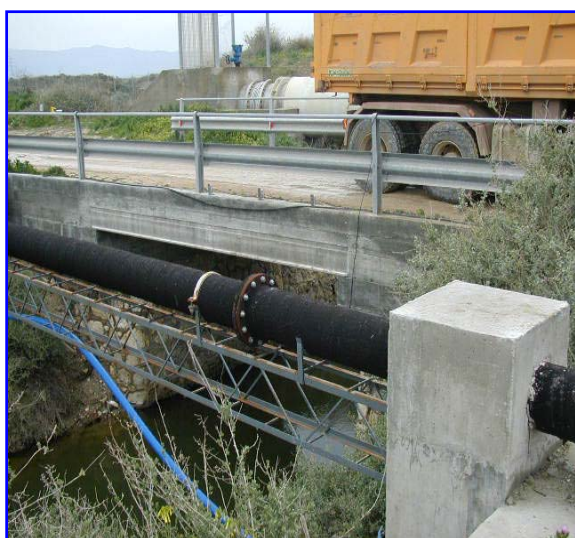
Foto 11 : autocarro sulla spalla
