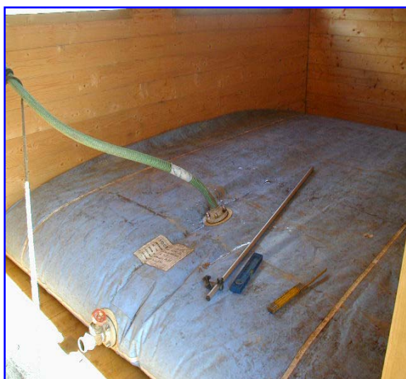
Foto 7 : applicazione del carico
