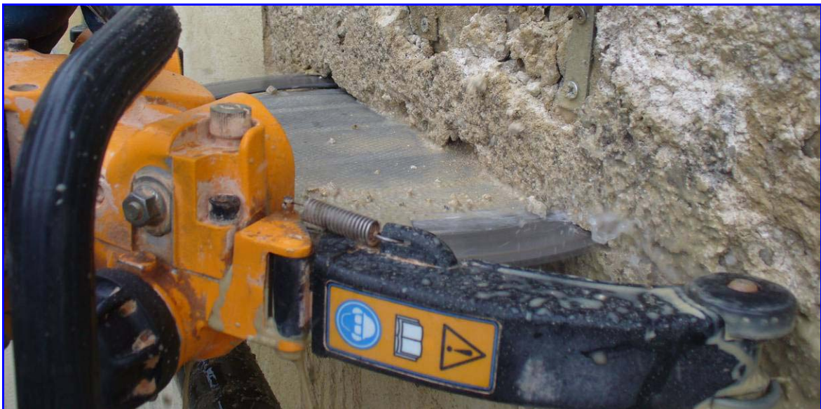
Particolare del taglio per l'inserimento del martinetto
