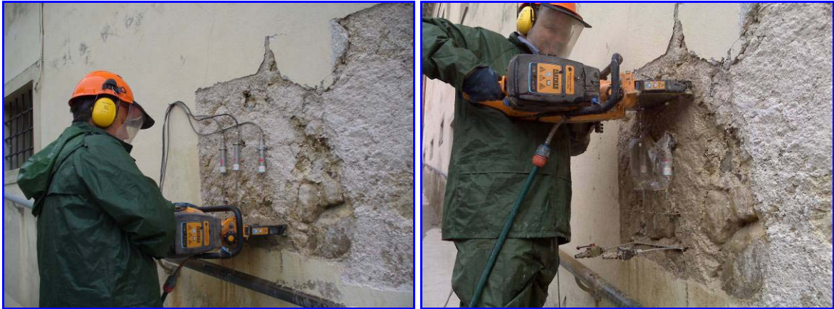
Esecuzione dei tagli
