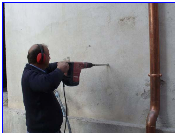
Esecuzione del foro d'ispezione
