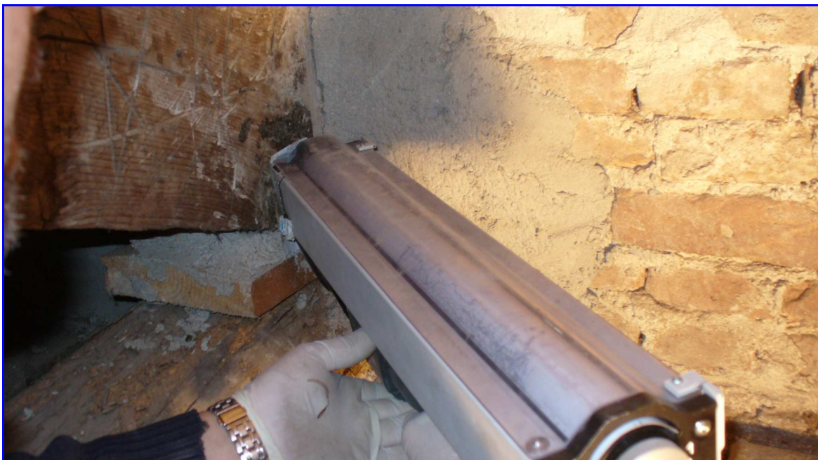
Perforazione eseguita a 45° sulla testa della trave
