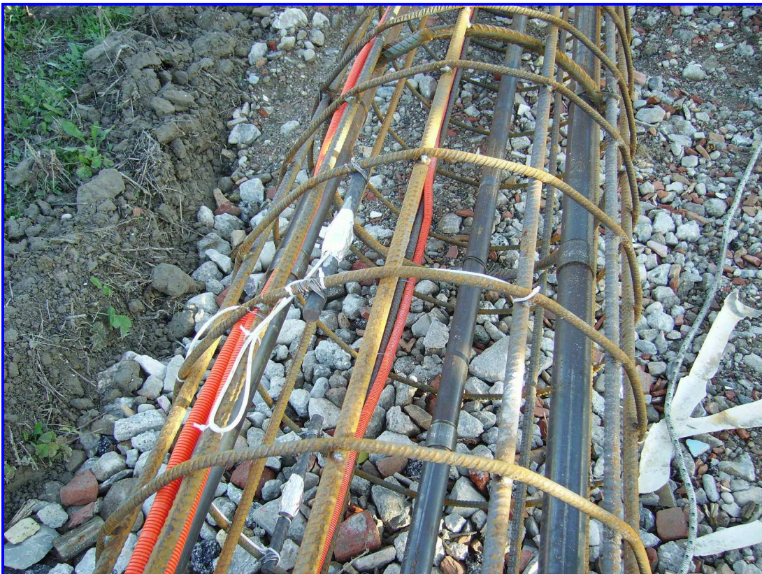
Armatura del palo
