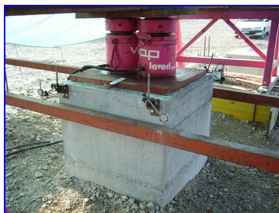
Palo sotto carico
