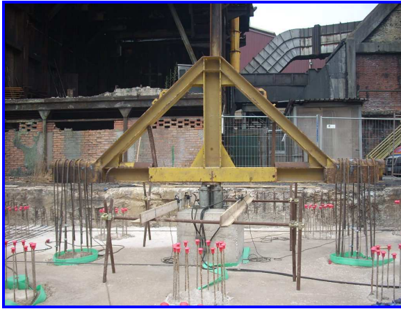
Area di prova su palo F 5-2
