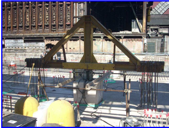
Area di prova su palo F 6-7
