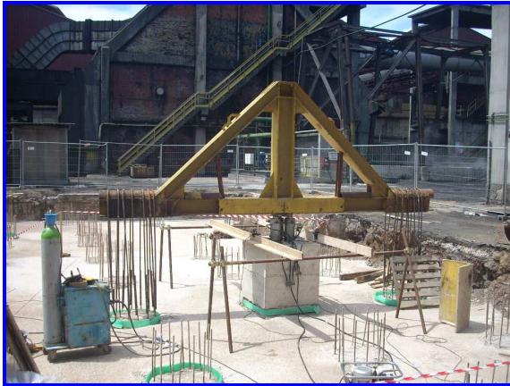
Area di prova su palo F 2-6
