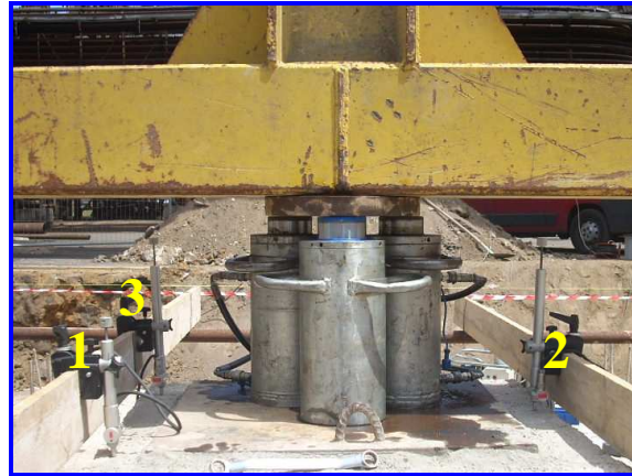
Particolare sensori e martinetti
