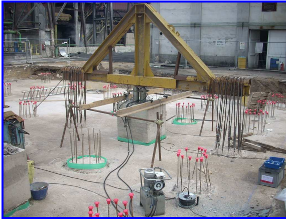
Area di prova su palo F 4-7
