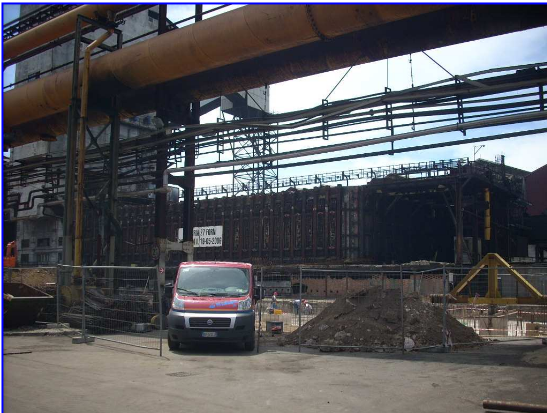
Cantiere interno all'acciaieria – Piombino (LI)
