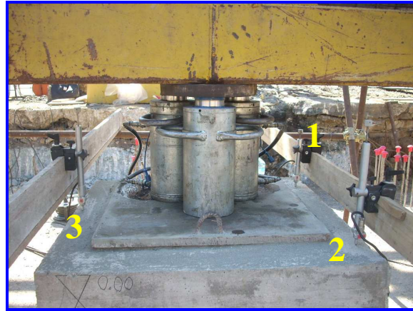
Particolare sensori e martinetti
