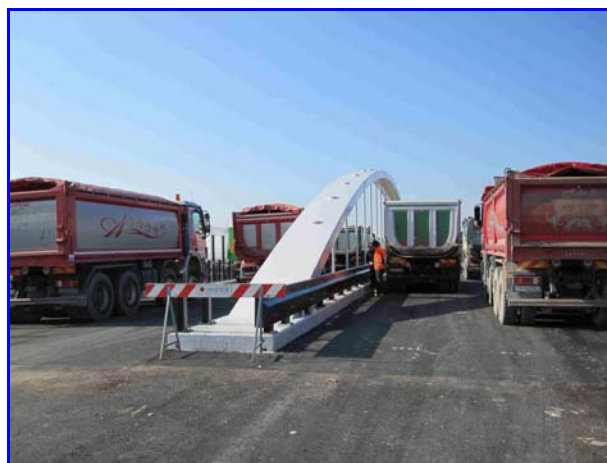
Foto 2: Vista longitudinale da est del ponte durante la prima configurazione di carico
