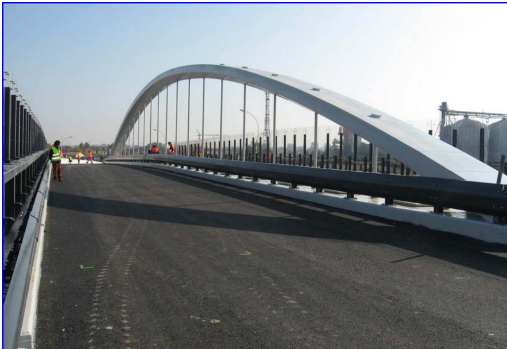
Vista longitudinale del cavalcavia del casello di Pegognaga (MN)
