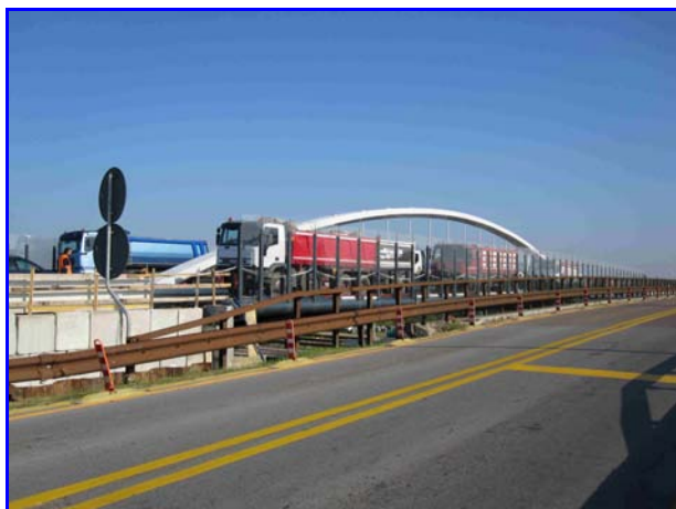
Foto 9: Vista del ponte da sud-ovest
