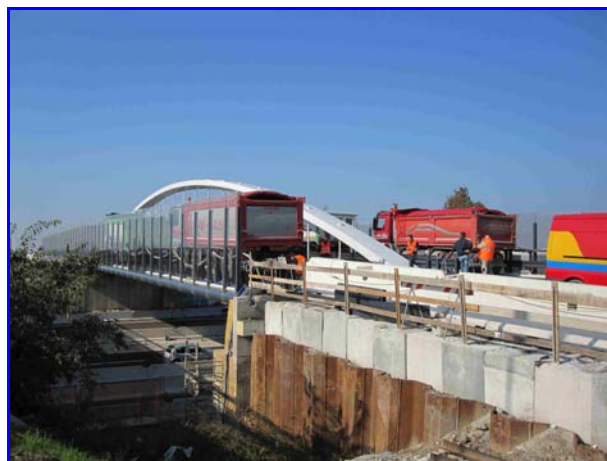
Foto 10: Vista del ponte da sud-est
