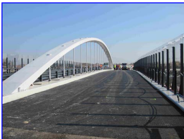
Foto 1: Vista longitudinale da ovest del ponte scarico
