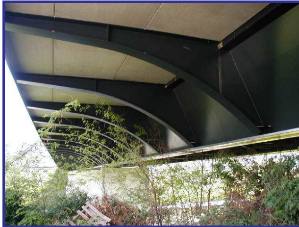
Intradosso della struttura
