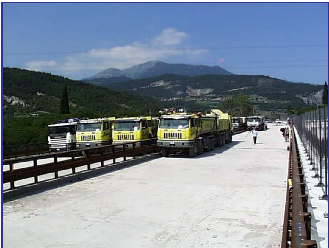
Viadotto sul xxxxxxxx
