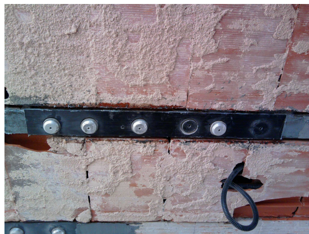
Foto 6: Provini dopo l'estrazione zona "B"
