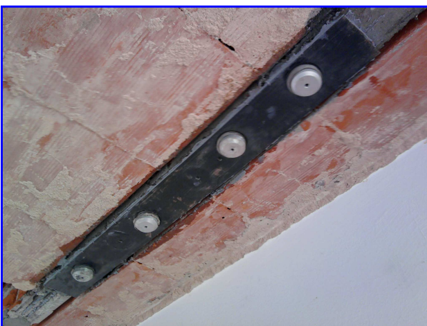
Foto 7: Intradosso del travetto zona "C"
