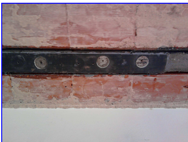
Foto 13: Intradosso del travetto indagine C
