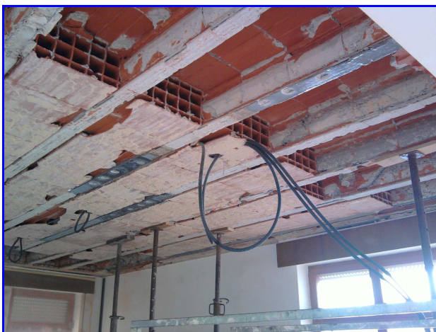
Foto 3: Intradosso dei travetti oggetto delle prove
