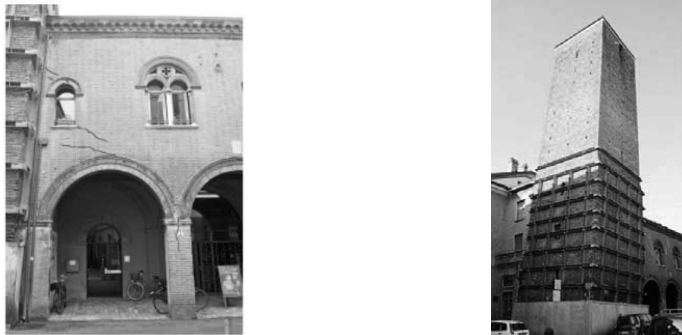
Figura 21: Interazione tra la torre Civica e Casa Melandri (RA)
