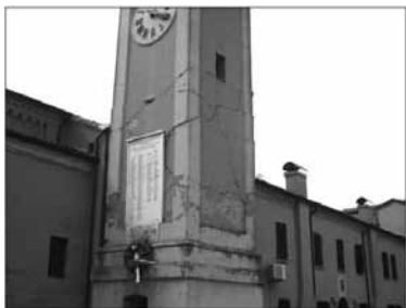
Figura13: Facciata sud ed est del campanile di Casumaro Cento (FE) in seguito al sisma dell'Emilia del 2012 e sistema di pronto intervento a puntello
