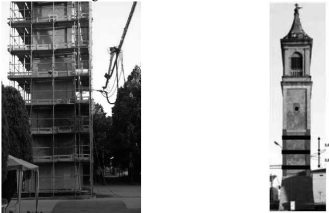
Figura 17: Campanile di Reno Centese: applicazione di betoncino proiettato e bendaggio con FRP
