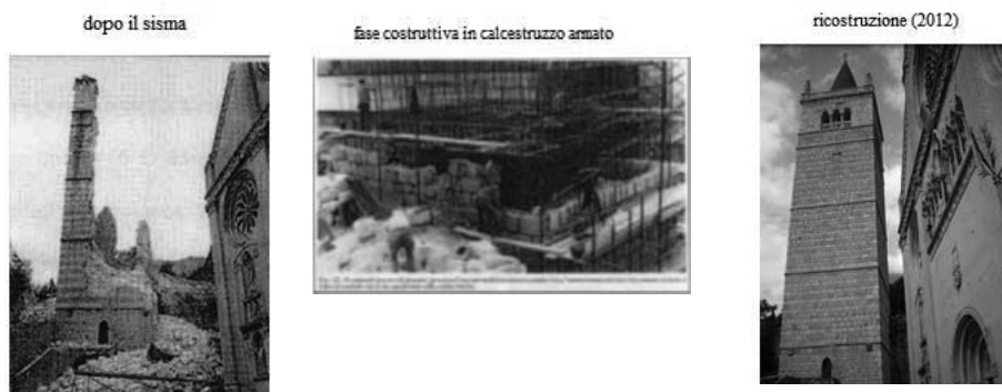
Figura 4: Campanile di Gemona (UD): crollo e successiva ricostruzione
