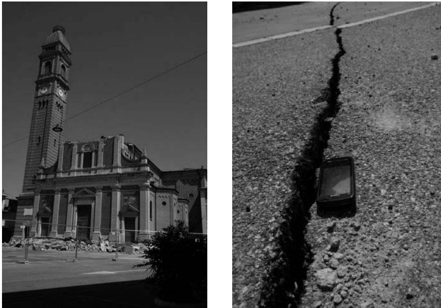
Figura 6: Campanile di Mirabello (MO) in seguito al sisma dell'Emilia ed esempio di frattura al suolo conseguente al fenomeno della liquefazione [3]
