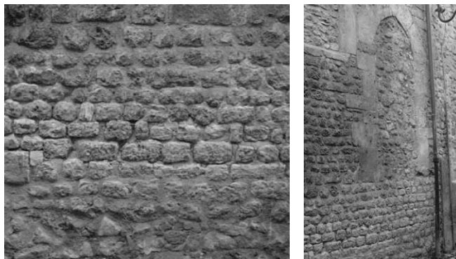
Figura 6 : Il cosiddetto “apparato aquilano”, la tipica tessitura muraria del centro storico di L’Aquila
