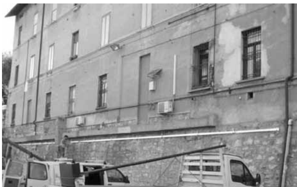
Figura 3: Installazione della batteria di elettrolivelle in corrispondenza delle fondazioni degli edifici
