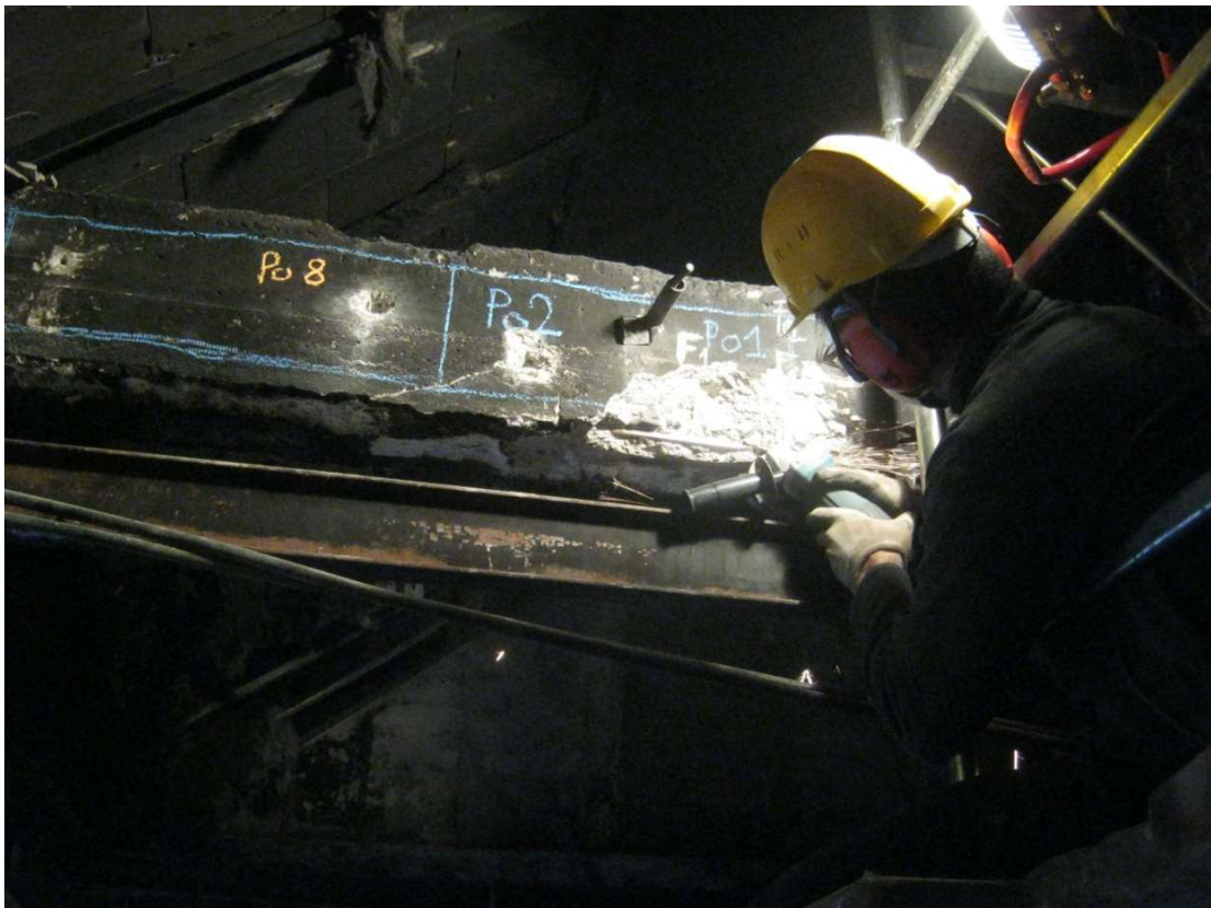
Figura 10: Preparazione della superficie del ferro d'armatura per l'esecuzione delle prove di durezza Leeb. Si notino le tracce delle armature tracciate sull'elemento strutturale in colore blu.
